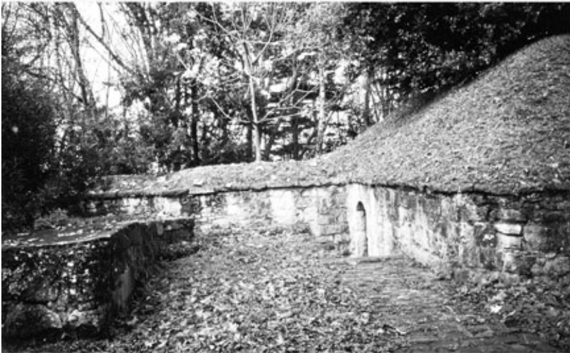
Bateria Alta del Príncipe. A la izquierda, la explanada para el OBC de 21 cm sobre montaje "Seraing". Al frente, el muro de mampostería que recubre el macizo de hormigón. A la derecha el través.
