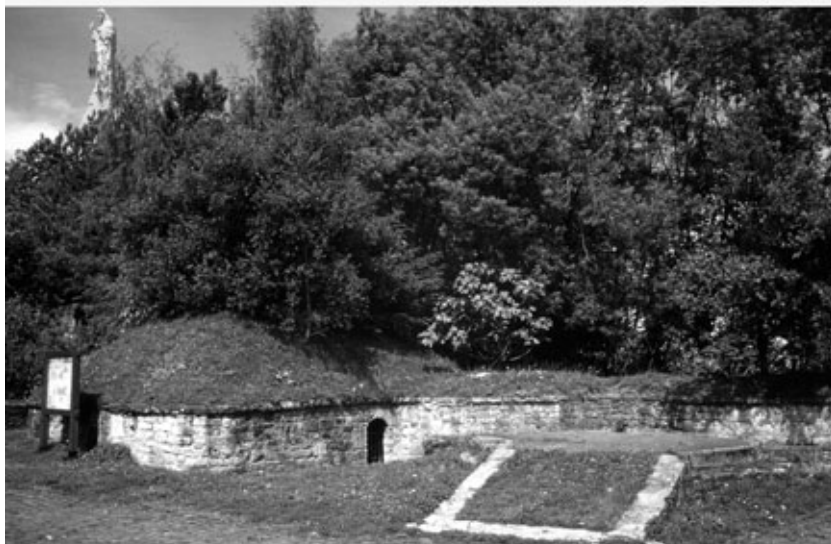
Batería Alta del Príncipe. Estado actual. En primer plano, la rampa de acceso a la explanada del OBC de 21 cm sobre montaje Lerdo-Milán. A su izquierda, el través.
