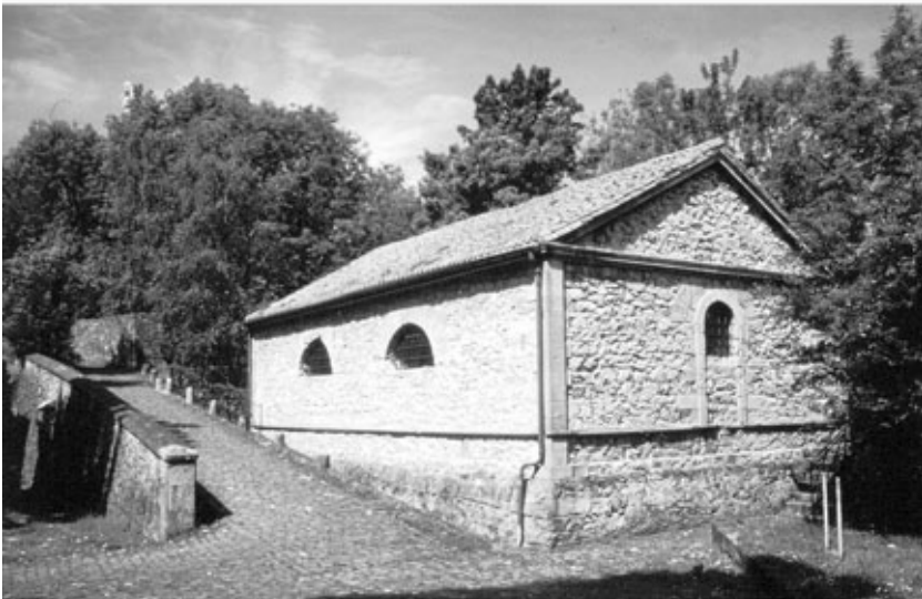
Batería baja del Príncipe. Cuerpo de guardia (1866). A su izquierda, la rampa de comunicación con la Batería Alta. Estado en el año 2002.
