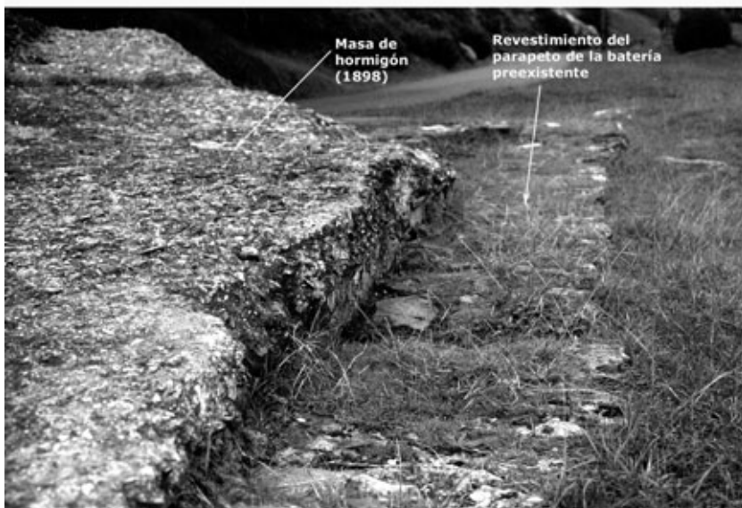
A la izquierda de la fotografía, el sector de hormigón del parapeto. A la derecha, a ras del suelo actual, restos del muro de mampostería que formaba el recubrimiento interior del parapeto de la batería preexistente y que constituye el límite exterior del bloque de hormigón.
