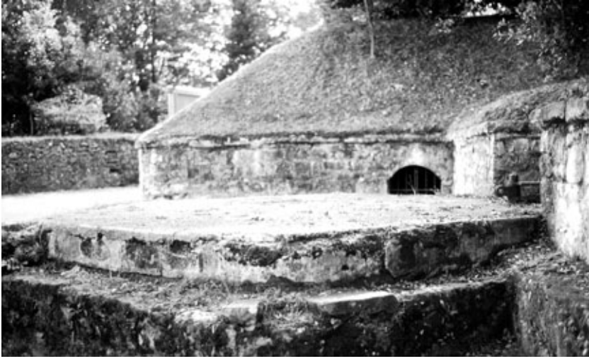
Bateria Alta del Príncipe. En primer plano la explanada para el OBC de 21 cm sobre montaje Lerdo-Milán. Se aprecian los los escalones de acceso. A la derecha el rebaje en el parapeto con el enganche para el freno. Al fondo, el través, apreciándose la entrada a los dos repuestos de municiones.
