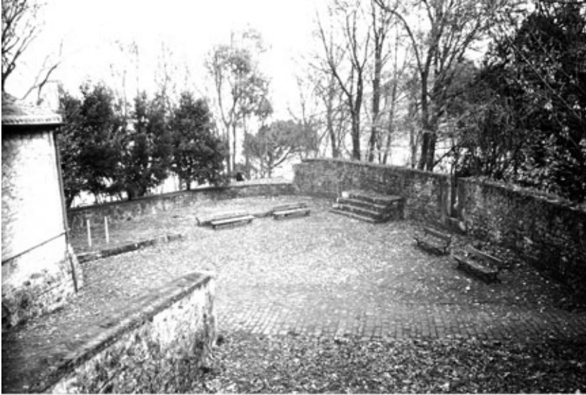
Batería baja del Príncipe. Estado en el año 2002. A la izquierda, el cuerpo de guardia (1866). A su derecha, el sector de parapeto bajo modificado en 1896 para instalar las dos explanadas para OBC de 21 cm en montaje Seraing que fueron conservadas en 1898. A continuación, el sector de parapeto alto con su banqueta y una de las dos cañoneras.
