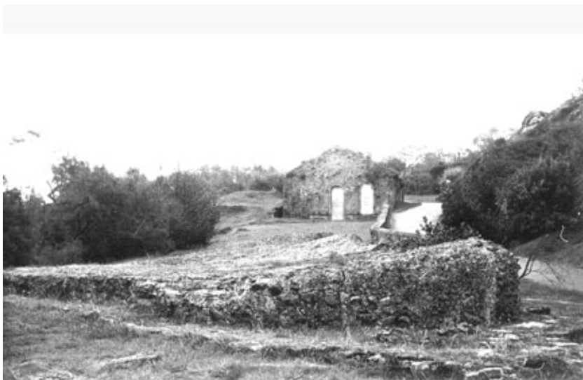
Batería de Bardocas. En primer plano el bloque de hormigón que forma parte del parapeto y que contiene en su interior un repuesto de munición. Actualmente desprovisto de su blindaje de tierra. Al fondo el cuerpo de guardia (1866).
