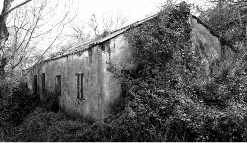
Posible barracón del campamento del Alto de Orio. Estado en 2004
