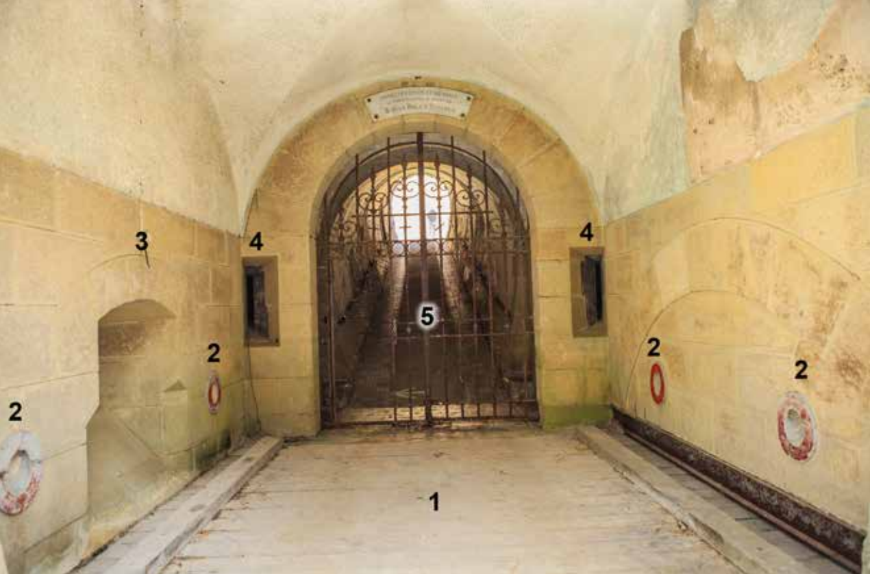
1 Foso con puente corredizo. 2 Cuatro lanzaproyectiles hacia el foso. 3 Matacán. 4 Dos aspilleras verticales. 5 Rastrillo de cierre con portillo. Al fondo, se aprecia la poterna en rampa de acceso al patio de armas.
