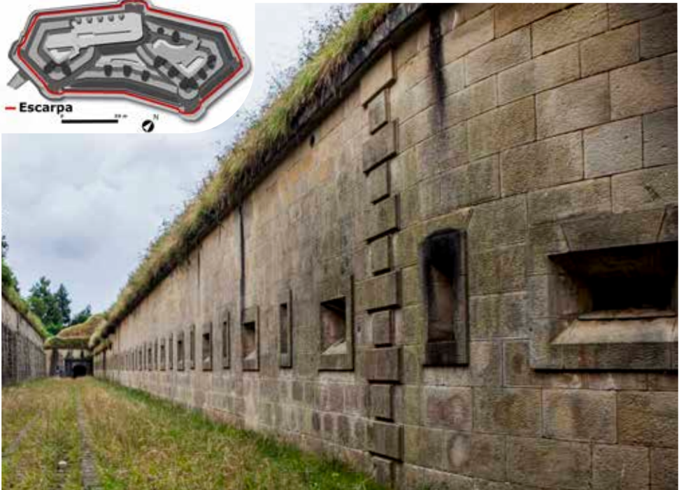
Escarpa de la Obra de la Izquierda, con su galería aspillerada. Al fondo la caponera de gola.
