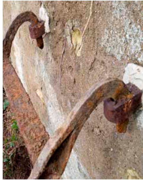
Escalera de parapeto en sus anclajes en el revestimiento del parapeto.
