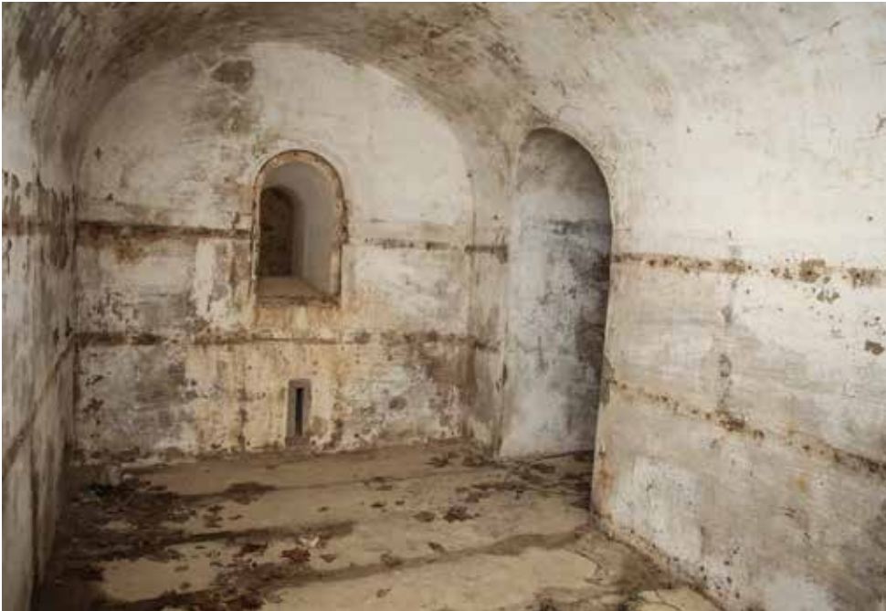
Depósito de distribución de la Obra del Centro (5). Interior de uno de los depósitos. Al frente se aprecia la ventana de iluminación y a la derecha el acceso desde la bóveda de comunicación. En el suelo de hormigón y en las paredes enfoscadas se perciben vestigios del entarimado de pino sobre rastreles formando cámaras de aire.
