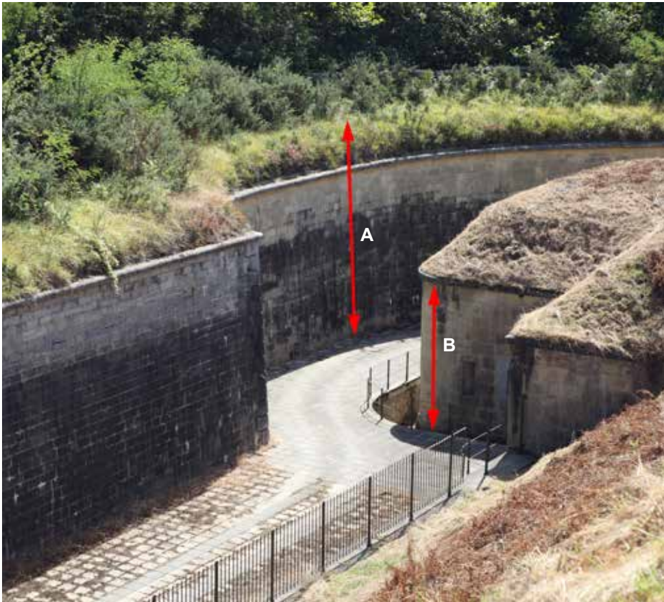
En la fotografía se comprueba que la caponera (A) es más baja que la contraescarpa (B).
