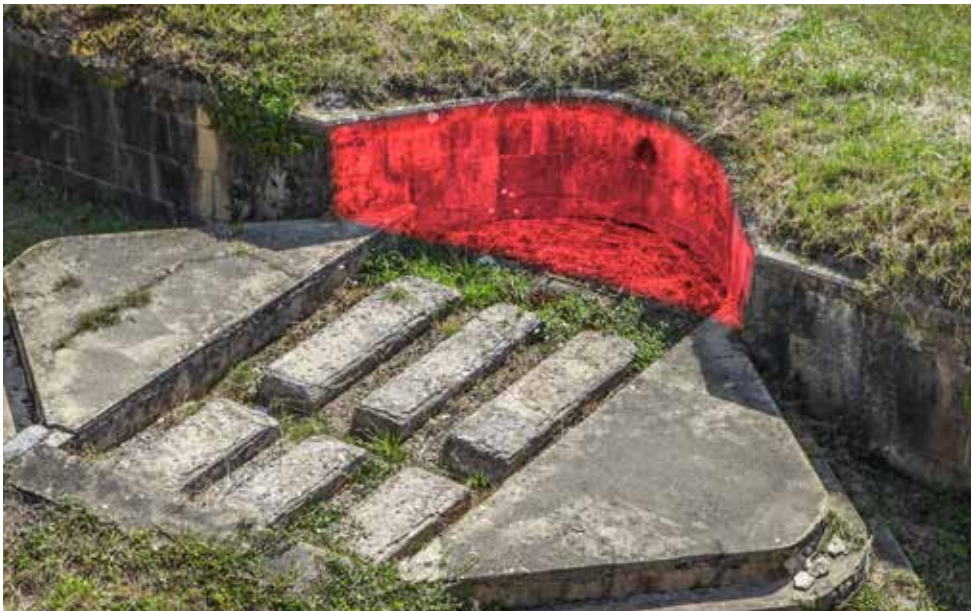
Semicilindro entrante (en color rojo) en el parapeto para un Cañón de Bronce Comprimido de 12 cm «Plasencia» en la Obra del Centro.
