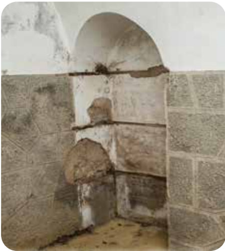
Armario en la caponera del Sureste. Se conservan vestigios de la fijación de tres estantes. Posiblemente no dispuso de puertas de cierre.
