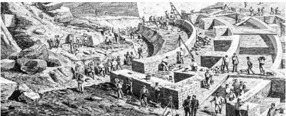
Dos fotografías de la construcción de las mamposterías de los fuertes de Rapitán hacia 1888 (Jaca, Huesca) y un grabado de San Cristóbal (cercañas de Pamplona) en 1882. Muy parecido aspecto tuvo que ofrecer el fuerte de Guadalupe durante la primera fase de su construcción, de la que no se conocen fotografías.
