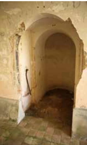
Estación superior del montacargas de la batería de morteros de la Obra de la Izquierda (4). No fue instalado..
