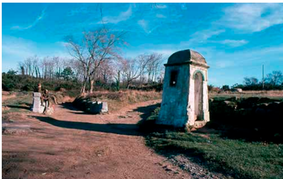
Estado de la entrada del fuerte en 1980. Se aprecian los caminos sin hormigonar y dos soldados conversando en la embocadura del camino de acceso, así como la garita de vigilancia. Fot. Archivo Municipal de Irun.
