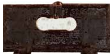
Porta de aspillera en la galería de escarpa.
