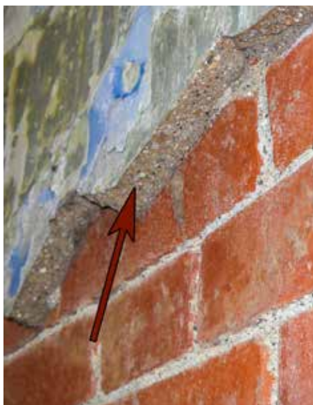
Enfoscado de un muro de ladrillo en los pabellones de oficiales de Infantería en la Obra de la Izquierda. Se aprecia su considerable grosor, superior a los 2 cm.
