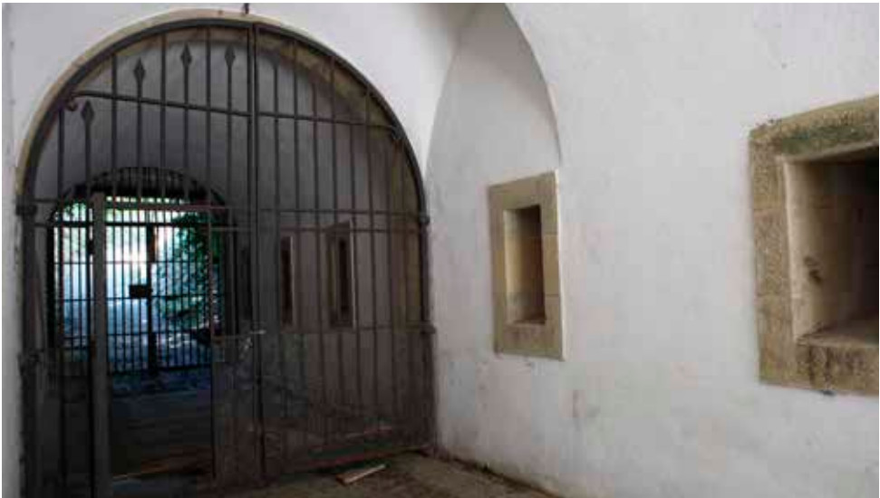
Túnel de acceso visto desde el foso. Se aprecian cinco de las seis las aspilleras que lo defienden y en primer plano la reja o rastrillo original. Al fondo, el camino de acceso y un cierre metálico de reciente instalación.
