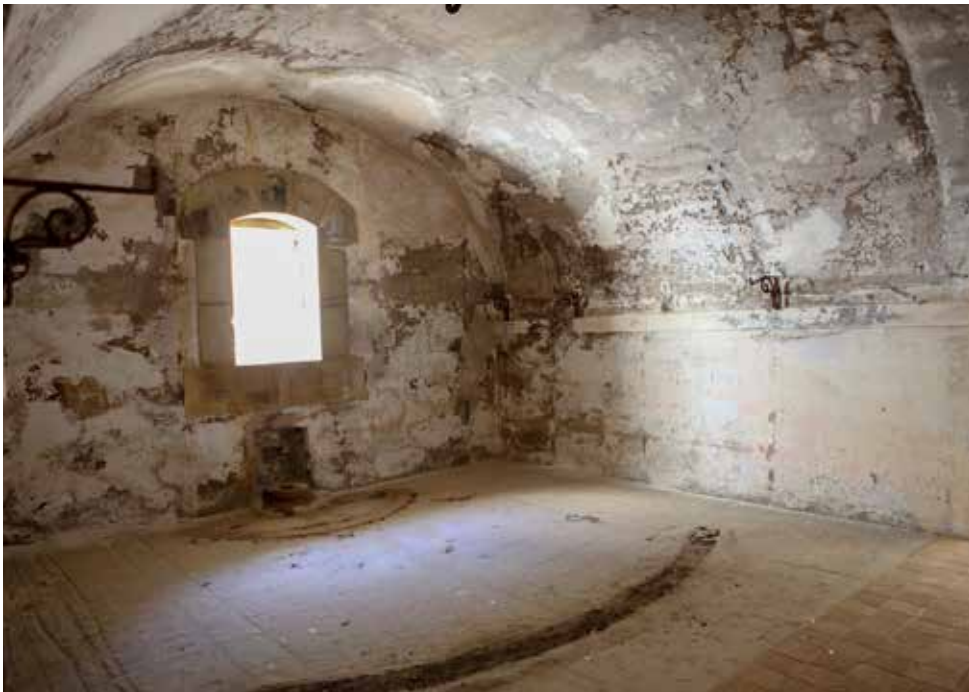
Basacaril (2) bajo una de las cañoneras del frente sur de la batería acasamatada de la Obra de la Izquierda, enfrentada a una cañonera túnel (actualmente cerrada).
