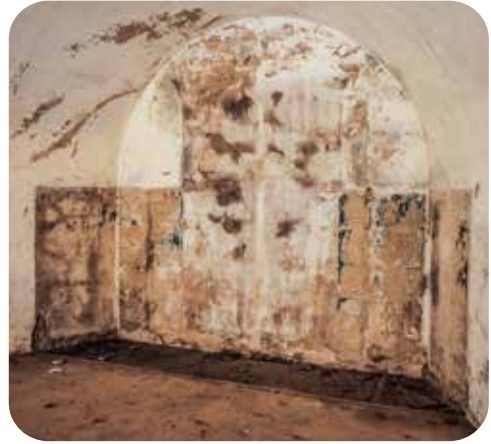
Vestigios de un armario, previsiblemente de madera. Se encuentra en la bóveda oriental de la batería acasamatada, correspondiendo a la planta superior del depósito de distribución de munición.
