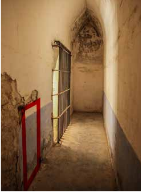
Espacio tabicado para la instalación de una estufa en el pasillo de comunicación entre los pabellones de oficiales de Infantería y la poterna de comunicación entre el patio de Armas y el patio de infantería.
