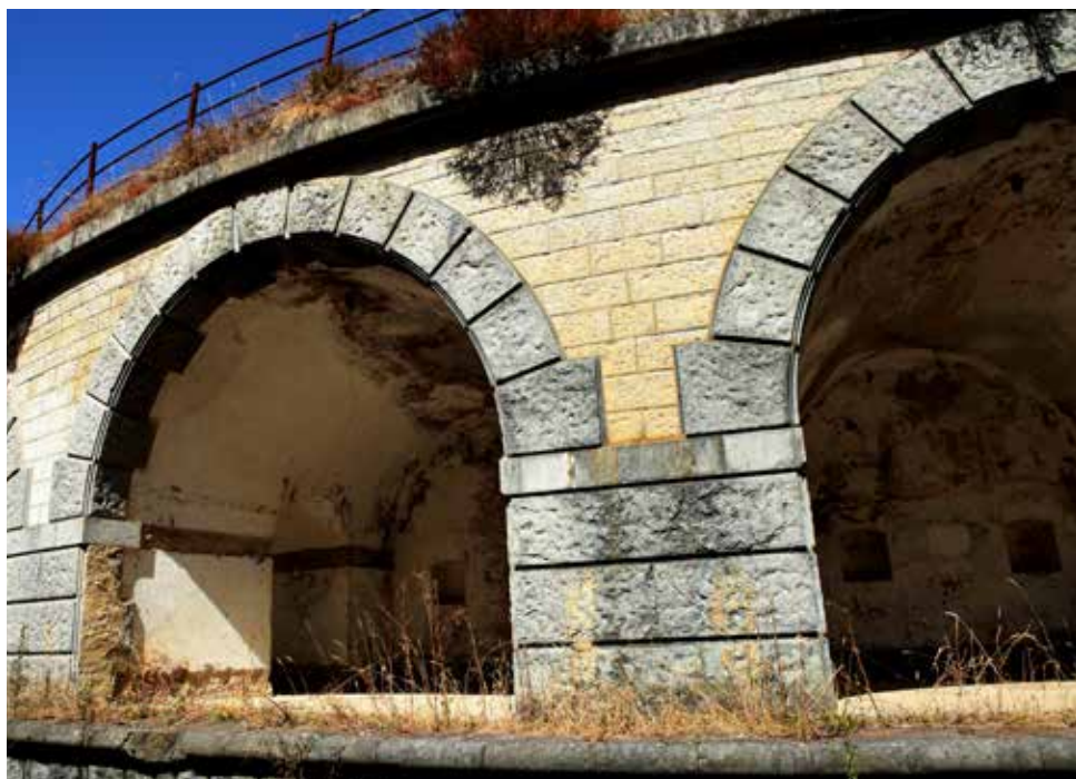
Bóvedas cónicas de la batería de fuegos curvos de la Obra de la Derecha.
