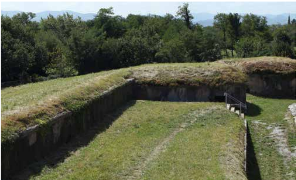
Otro ejemplo de batería a barbete en el Fuerte son los diversos frentes de la Obra de la Izquierda, en este caso sin explanadas para las piezas de artillería..
