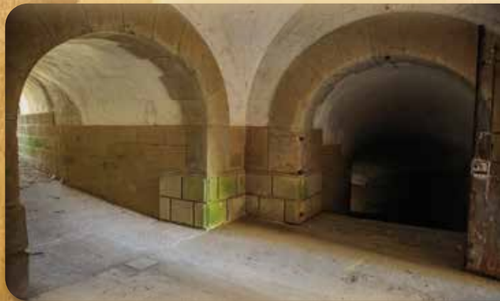
Accesos a las dos poternas que comunican el patio de Infantería y los dos patios de la Obra de la Derecha. (5 y 6).
