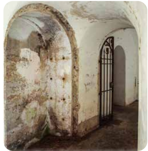
Armario situado entre la casamata oriental de la batería de fuegos curvos de la Obra de la Derecha y su repuesto de munición.
