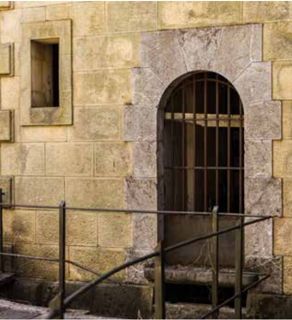
Puerta de guerra de la semicaponera SW (3). Disponía de un puente móvil sobre el refosete del que perduran actualmente algunos vestigios (la barandilla del refosete es actual).
