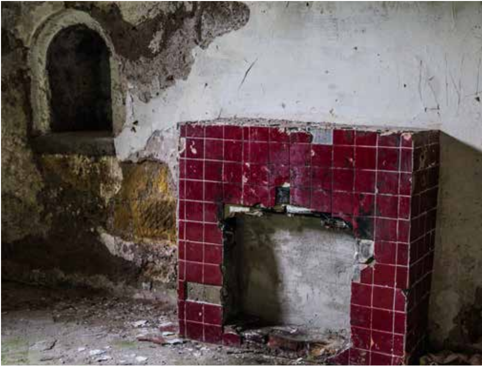
Chimenea cegada en el sala /comedor de los oficiales de Infantería. A la izquierda se aprecia el vano para el paso de la comida entre la cocina y el comedor.
