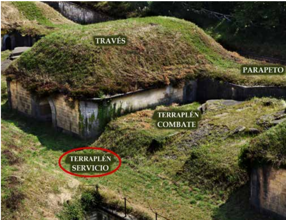
Terraplén de servicio de la Obra del Centro.
