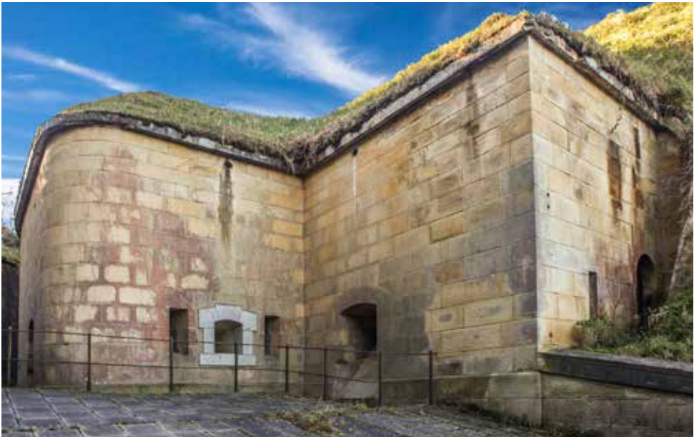
Flanco oriental de la caponera SW. (4) Se aprecia la cañonera y dos aspilleras de flanqueo y a su izquierda un matacán para defensa del fosete.
