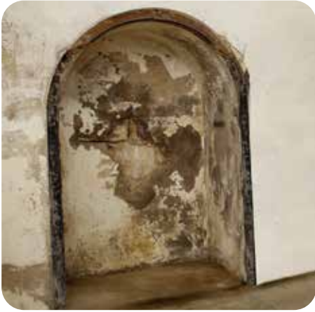
Armario en la bóveda occidental de la planta inferior del cuartel de infantería. Está situado al lado de la puerta que comunica esta estancia con la galería de escarpa.
