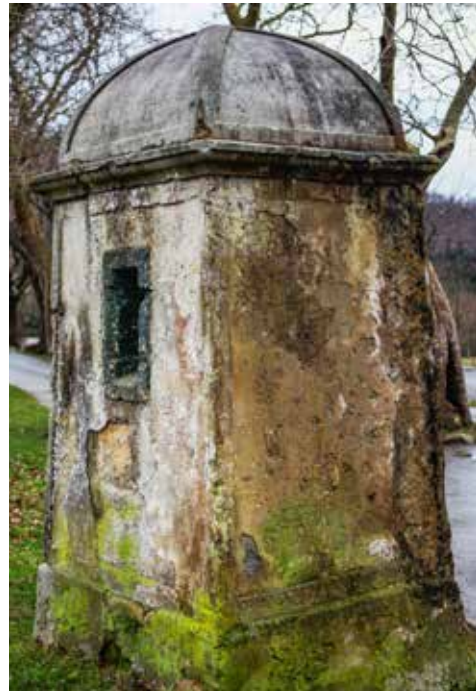
El lado de la garita opuesto a la entrada no posee mirilla.
