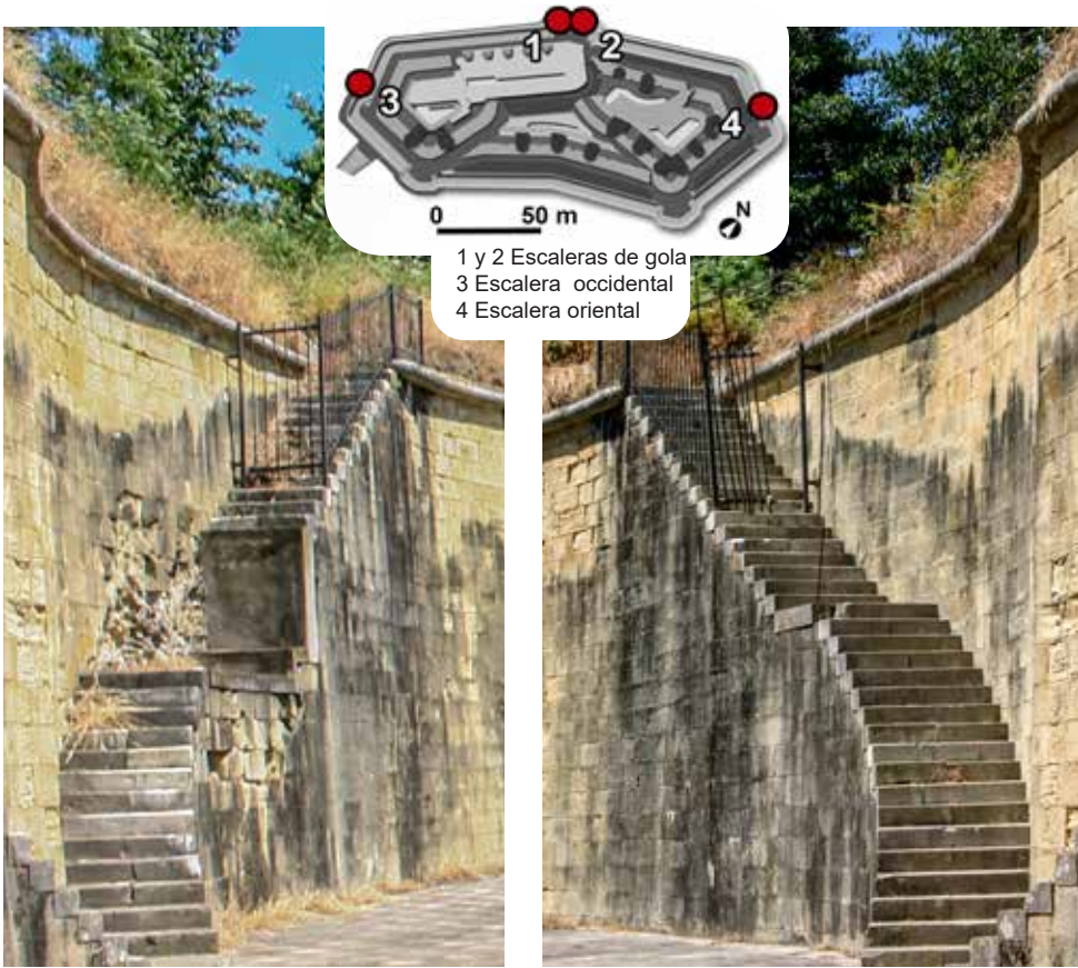
Escaleras de contraescarpa próximas a la caponera de gola. Son dos, adoptando forma curva para adaptarse a la curvatura de la contraescarpa en ese punto. La fotografía de la izquierda corresponde a la escalera número 1 del plano y la derecha a la n. 2
