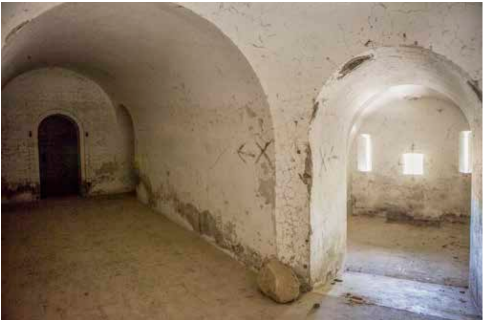
Caponera suroeste. A la izquierda bóveda de acceso (9) a las casamatas con el repuesto de munición (2) al fondo. A la derecha, la casamata oriental (1a), con su cañonera y dos aspilleras.
