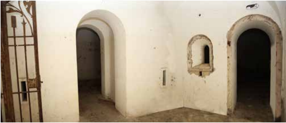
Vestíbulo e la batería de fuegos curvos de la Obra de la Derecha (F). De izquierda a derecha: reja de acceso a la batería (G), acceso al depósito de proyectiles (A), ventana de iluminación del Depósito de pólvoras y acceso al depósito de pólvoras (B). Faltan las puertas.
