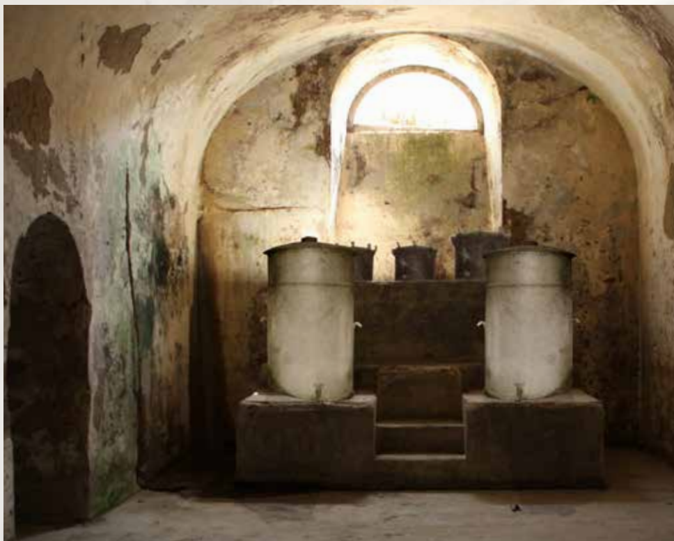
Fotomontaje del aspecto que ofrecería la sala de filtros a principios del siglo XX. El filtro grande estaría situado a la derecha de la imagen y vertería agua al depósito de acumulación derecho y los dos pequeños al depósito izquierdo.
