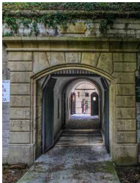
Exterior de la puerta de acceso al foso.
