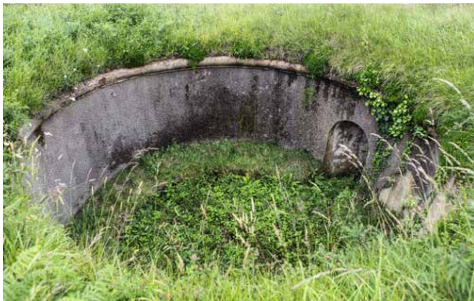
Entre las medidas de adaptación a las nuevas granadas se incorporaron en el Fuerte tres asentamientos para cúpulas acorazadas giratorias artilladas o para piezas de giro central, que nunca fueron instaladas.
