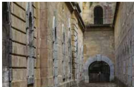
Patio de infantería. Sobre la boca de la poterna se observa un vano perteneciente a la estancia ( d ) aneja al observatorio.
