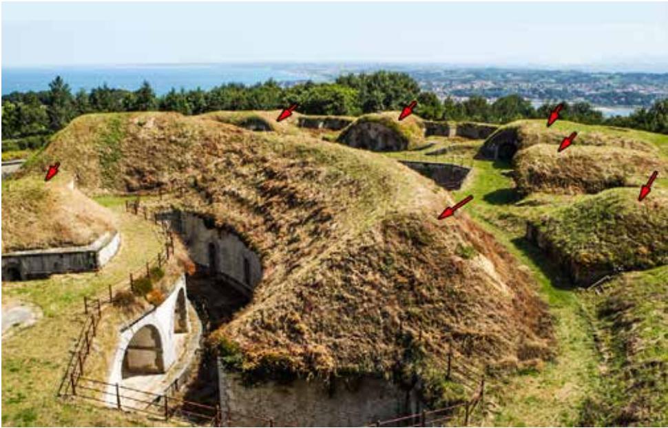
Principales blindajes superiores de tierra que cubren dependencias abovedadas de la Obra de la Derecha. En primer plano, el cuartel de artillería con su protección de tierra de sección triangular. El resto de los blindajes señalados con flechas corresponden a los traveses.
