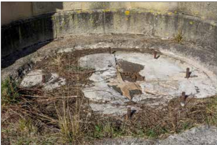
Vestigios de una de las basacarriles pertenecientes a los CHE de 15 cm que artillaron el frente norte de la Obra de la Derecha.
