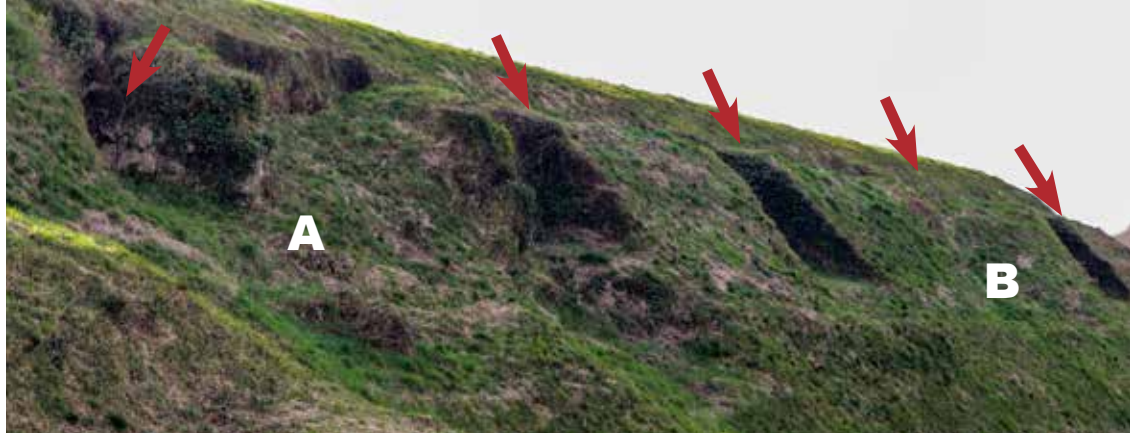
Exterior del frente norte de la batería acasamatada. Se observan las aberturas de las cañoneras (flechas) en el blindaje de tierra, desprendido (A y B) en dos sectores.
