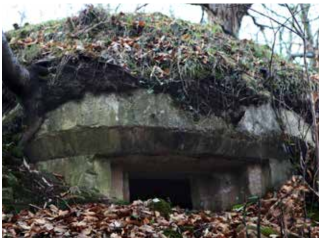
Centro de Resistencia 245 «Guadalupe», obra 32, nido para un fusil ametrallador. Situado 450 m al NE de la torre de Jaizkibel más próxima al fuerte de Guadalupe y a 815 m al suroeste del mismo.
