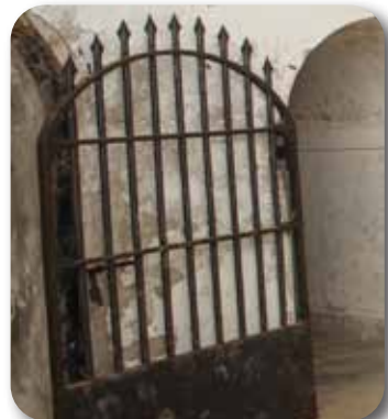
9 Cuartel de Infantería, modificada en su sector inferior.
