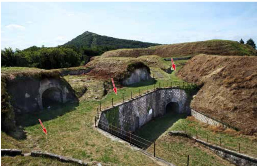
Terraplén de servicio de la Obra de la Derecha.
