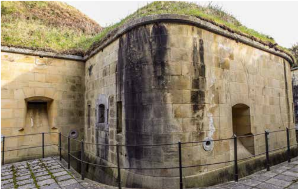
Caponera sureste Se aprecian varios matacanes, aspilleras, lanzagranadas y la cañonera para flanco del foso.
