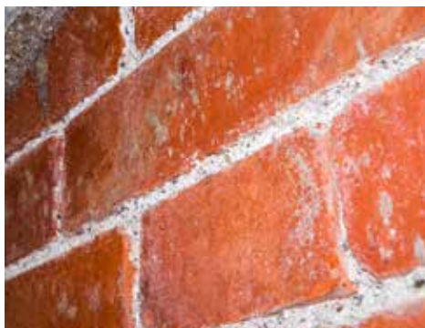
Muro de ladrillo en los pabellones de oficiales de Infantería, en la Obra de la Izquierda.
