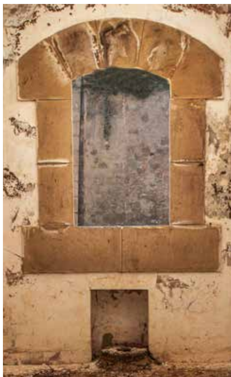
Batería acasamatada. Interior de la cañonera (B) orientada hacia el sur, frente a cañonera túnel, esta última cegada por un tabique. Bajo la cañonera se aprecia el hueco en el que sobresale el sector de basacarril, destinado a acoger al perno pinzote.
