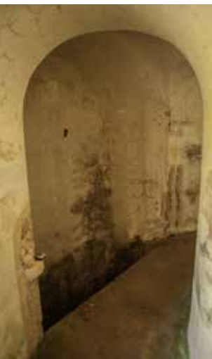
Estación superior en el través central del frente oriental de la Obra de la Derecha (3). Solo se conserva su caja.
