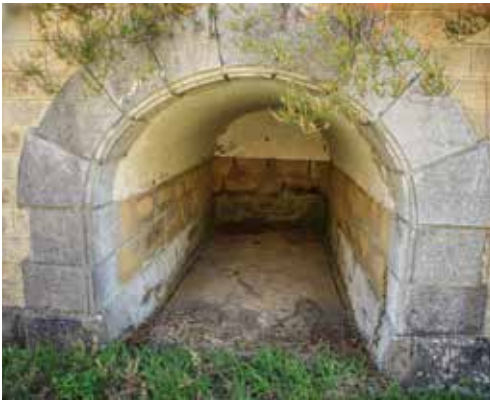
Abrigo (1) para artillería, Obra del Centro.
