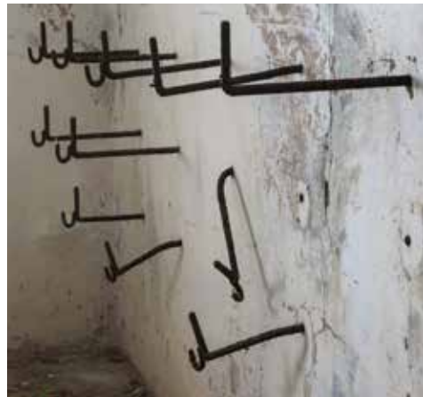
Soportes de juegos de armas en la batería acasamatada de la obra de la izquierda.
