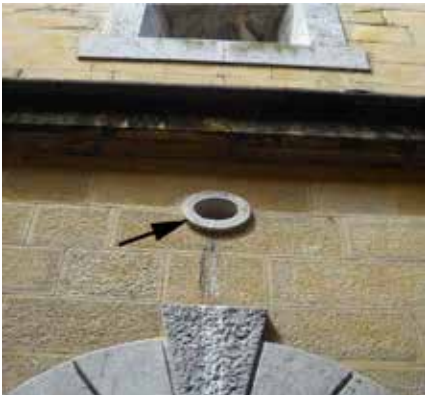
Cuartel de infantería: parte superior de ventanas y puertas al patio. Las bóvedas cerradas tienen otro ventilador que comunica cada una de ellas con el pasillo.
