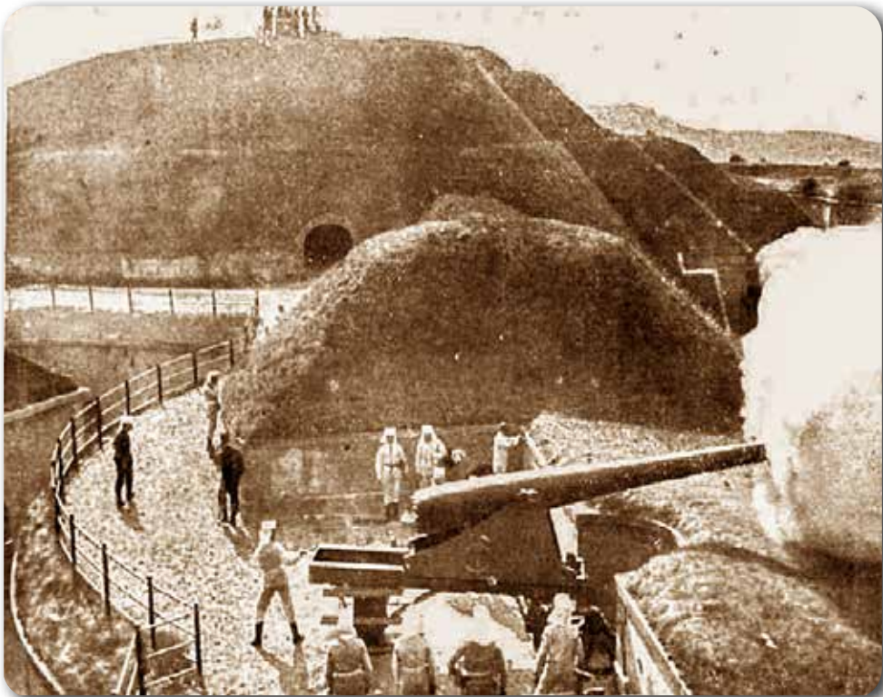
Fotografía de principios del siglo XX de un cañón Ordóñez de 15 cm sobre marco alto en el asentamiento oriental del frente norte de la Obra de la Derecha. Es una batería a barbeta en la que los servidores están a cubierto por el parapeto y es la boca de fuego la que sobrepasa la altura del mismo mediante un montaje de marco alto.
