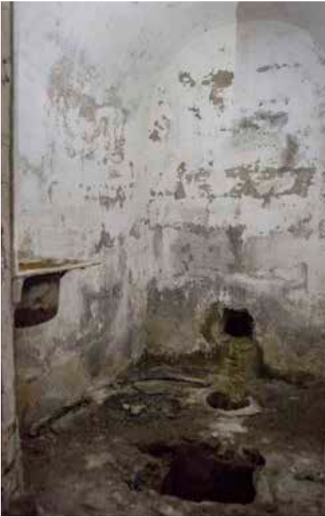
Una de las dos letrinas (7) monopuesto de la galería de escarpa. En primer plano se aprecia el registro abierto del pozo Mouras.
