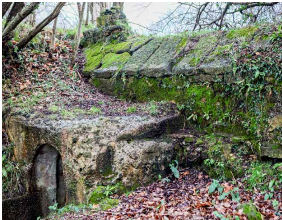
Revestimiento interior del parapeto y acceso al repuesto. Sobre él se aprecia una pequeña plataforma que podía ser usada como banqueta para fusilería o bien para a observación.
