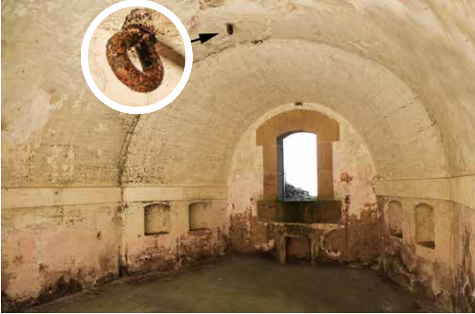
Argollón de suspensión en el frente norte de la batería acasamatada.
