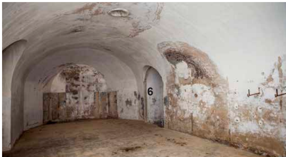
La planta superior acogía a la estación superior del montamunición (6) y conectaba con una vía férrea de municionamiento.
