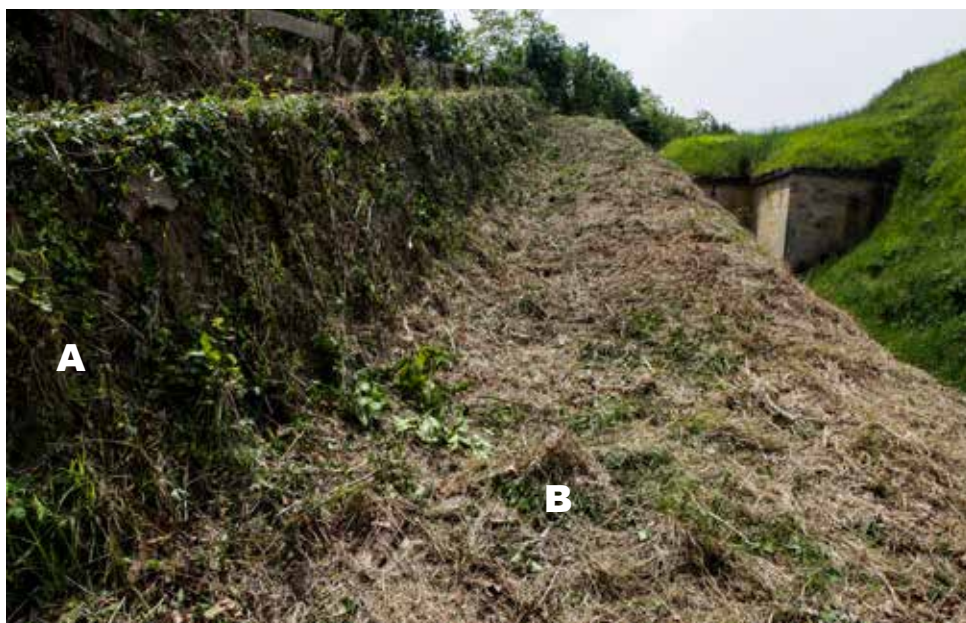
Camino cubierto y su parapeto ( A ) de fusilería en el tramo sur (revestido), perfectamente conservado, con excepción del suelo ( B ), que era de piedrilla sobre recebo de arena.
