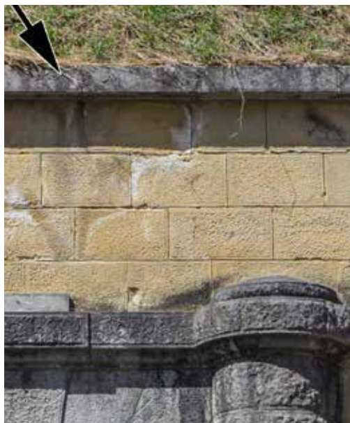
Cordón en la caponera de gola. Es de sección rectangular, pero cumple con la misma función de evitar que el agua escurra por el paramento exterior de los muros, además de rematar estéticamente el muro revestido de sillería arenisca, dando paso al blindaje de tierra.
