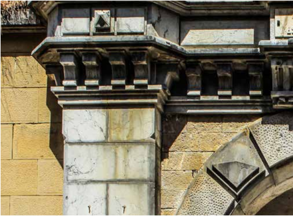
Detalle de sillería caliza (grisácea) y arenisca (amarillenta) en la puerta principal del Fuerte.
