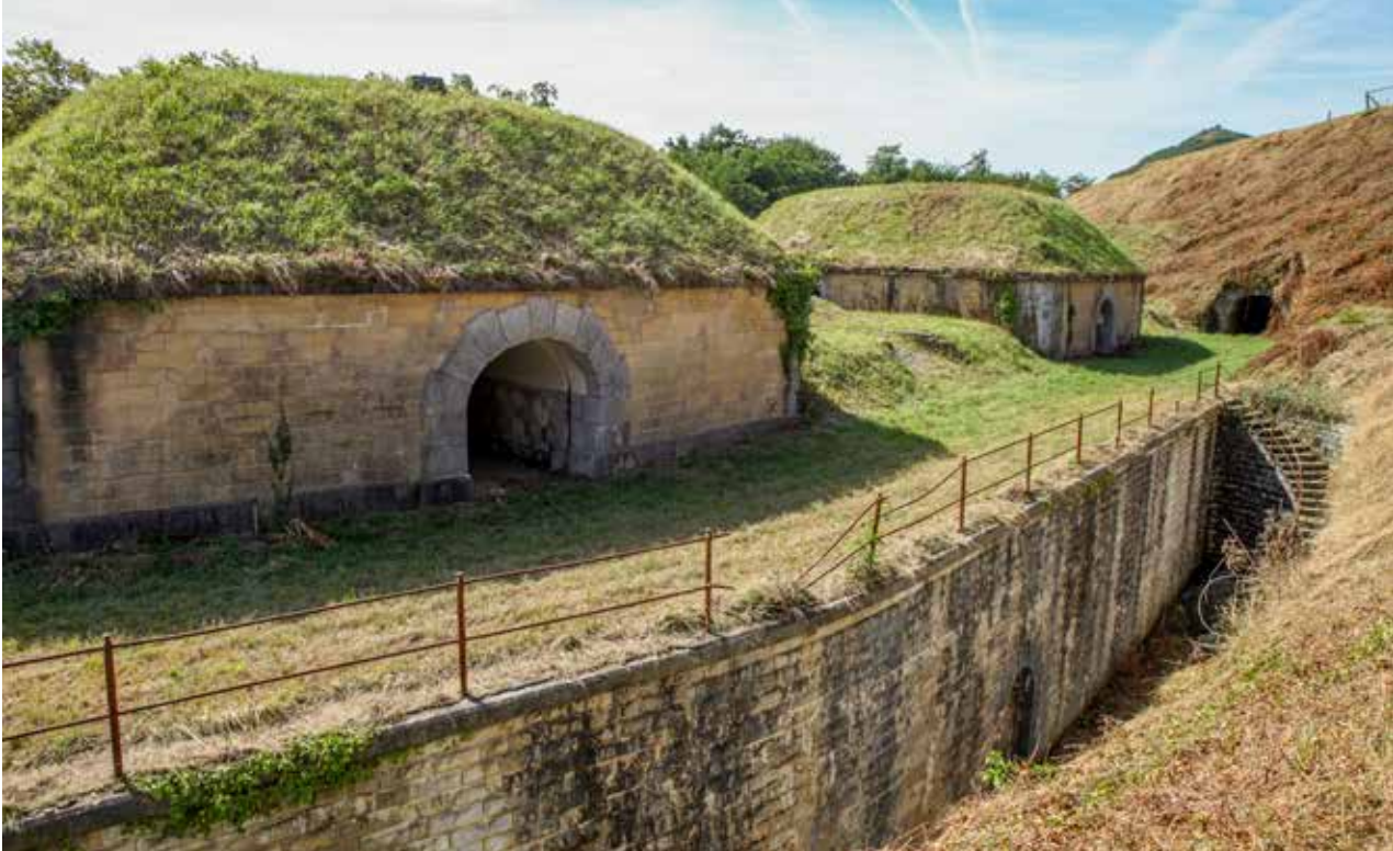
Obra del centro: patio de la obra, terraplén de servicio y traveses.
