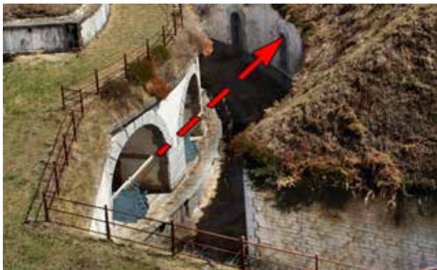
Batería de la Obra de la Derecha. Disparo salvando la cubierta del cuartel de artillería.
