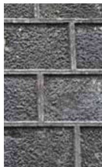
Sillarejo calizo, juntas encintadas.
