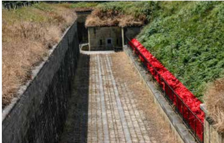
◁ Visión del camino de ronda a través de la aspillera específicamente diseñada para su control, al lado de la puerta de acceso al mismo.
