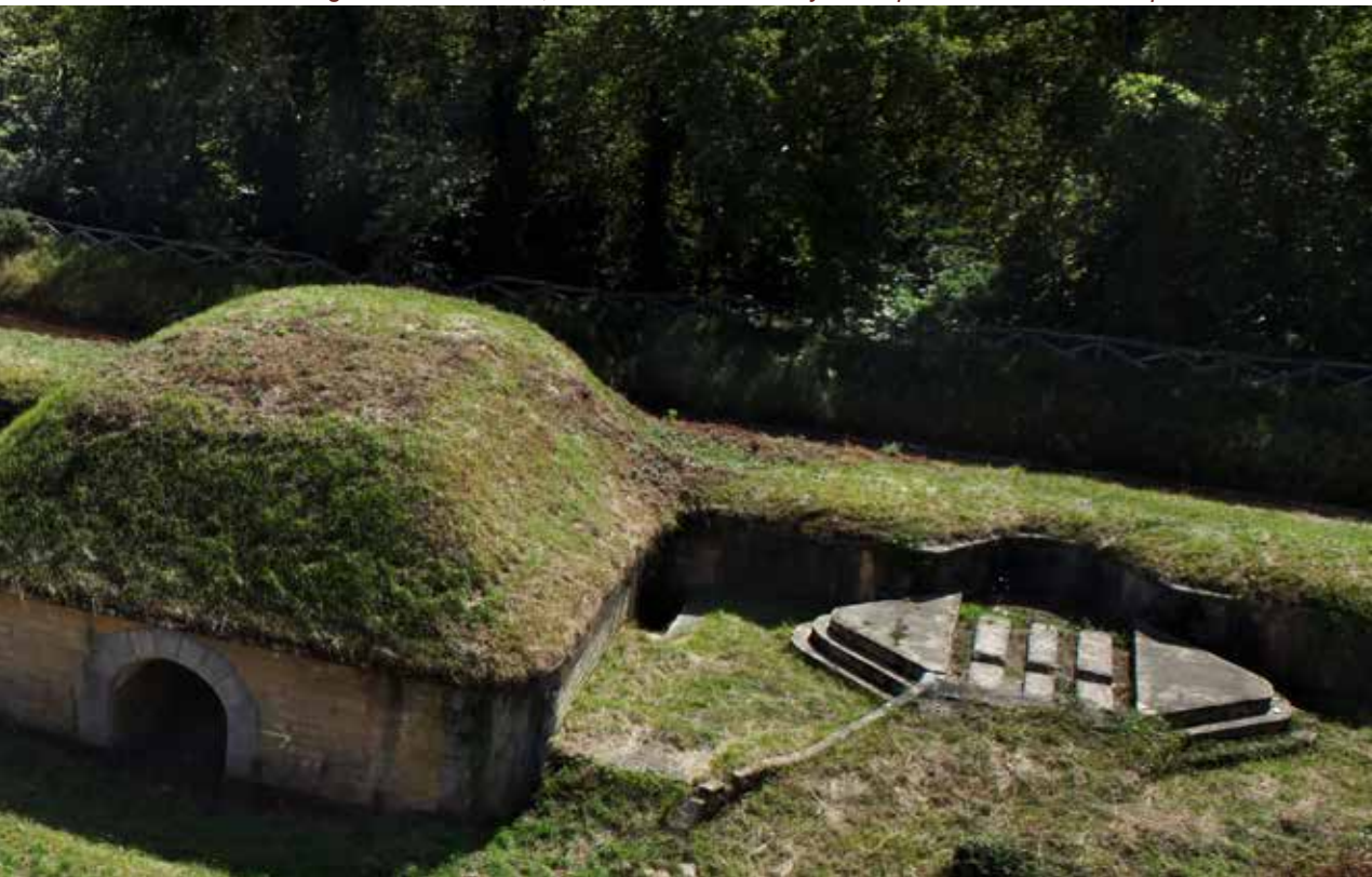
Vista general de la Obra, con sus tres traveses y las explanadas con sus rampas.
