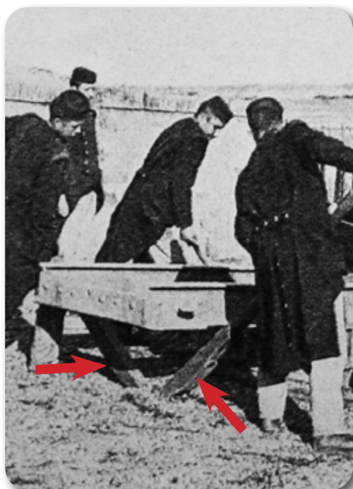
Los servidores apoyan los espeques en el suelo y en el marco de un obús, con objeto de moverlo haciendo palanca.
