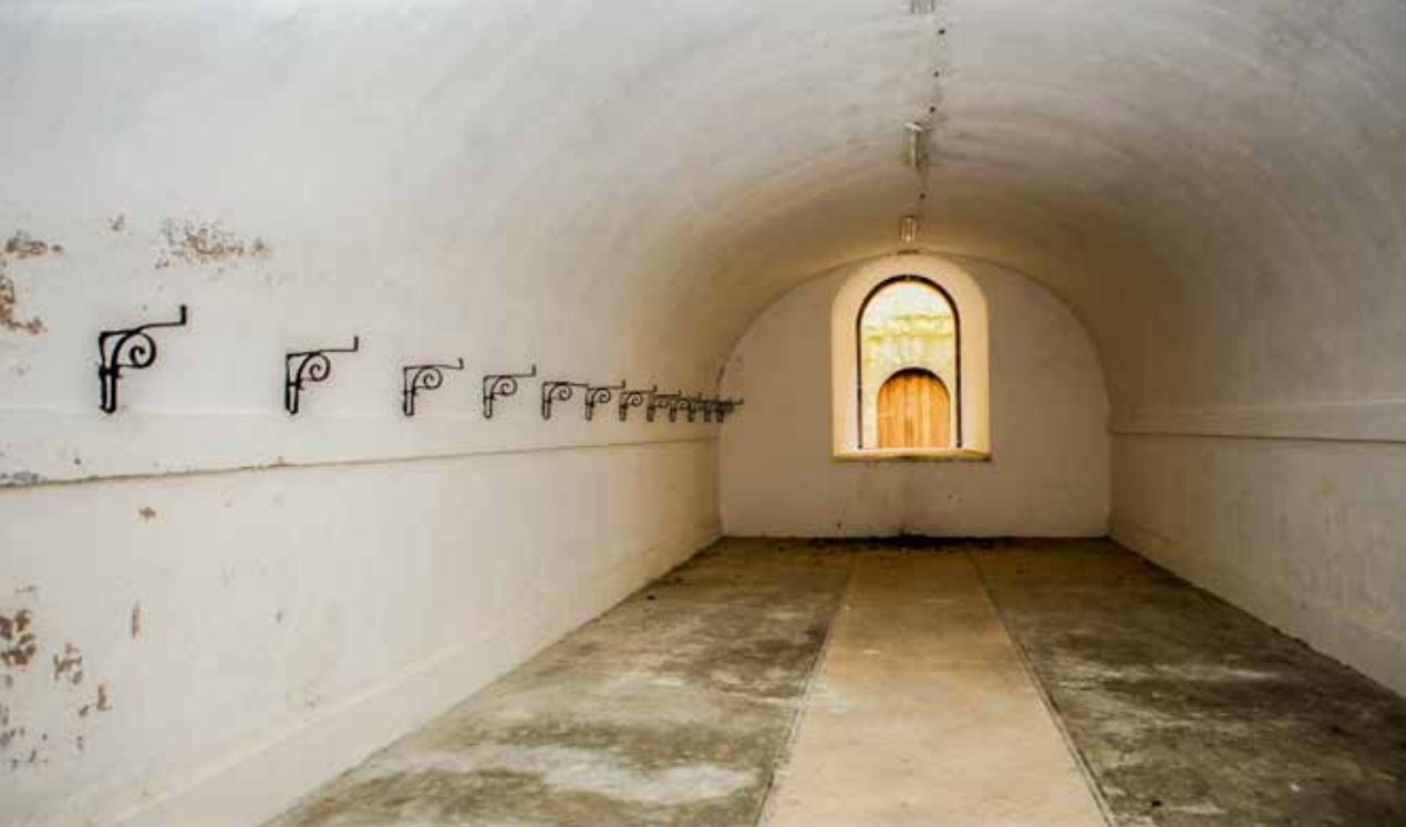
Bóveda en carpanel del cuartel de infantería. Al fondo, ventana hacia el patio de infantería.
