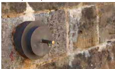
Grifo del depósito de reserva en la contraescarpa, cerca del cuerpo de guardia. Grifo y estructura metálica son actuales.
