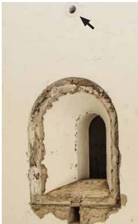
Ventana de luces del repuesto de la batería de fuegos curvos de la Obra de la Derecha. Vista exterior. En la parte superior (flecha) se aprecia la salida de humos.
