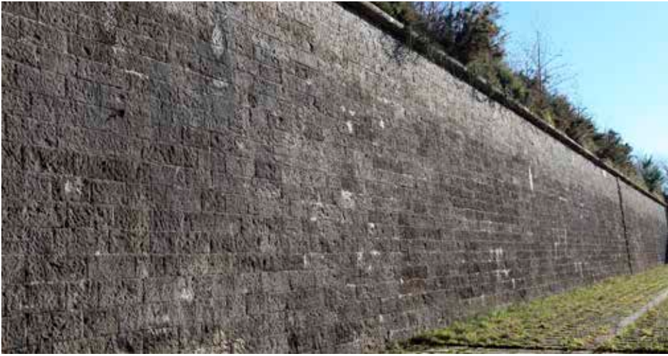
Contraescarpa del frente sur. Se aprecia que el revestimiento es de sillarejo calizo desbastado, rematado por un cordón, también calizo.
