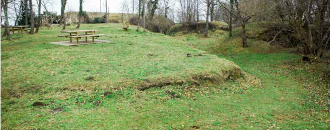
La batería vista desde el acceso. Al fondo se aprecia el Fuerte.
