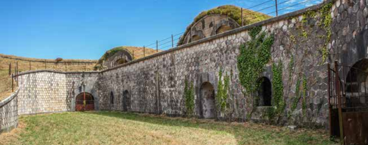
Patio oriental de la Obra de la Derecha visto desde su extremo sur. Se aprecia, a la izquierda, la rampa de acceso a los terraplenes de la Obra.
