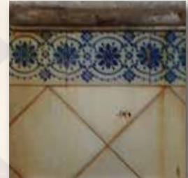
WC cuartel artillería.
