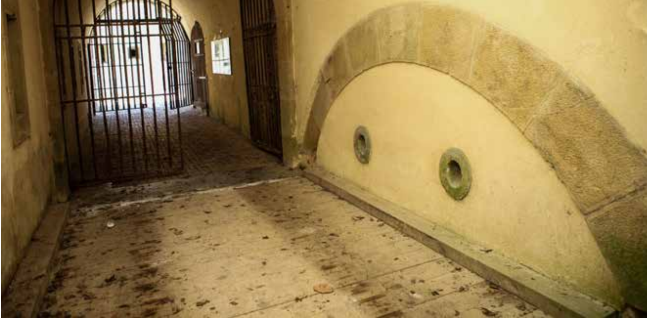
Interior del túnel de la antepuerta. En primer plano se aprecia el foso, cubierto actualmente por medio de una estructura fija de madera que simula el puente corredizo original. Nótese el arco de descarga del muro y las dos bocas de los lanzaproyectiles.
