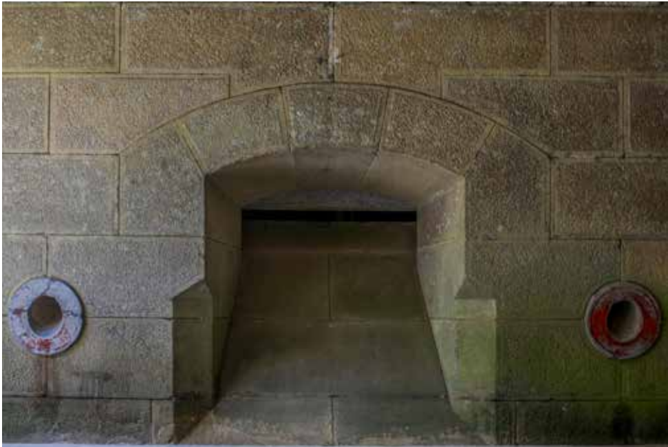
Matacán y dos lanzaproyectiles para la defensa del foso de la entrada principal.
