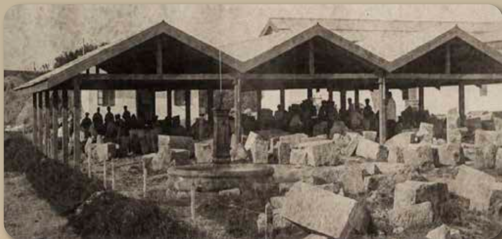
El campamento de obra estuvo situado en el entorno de la batería del Calvario. En el centro de la fotografía, el cobertizo del taller de cantería (13). En primer plano, la fuente (16) Fot: J. Roca. © Patrimonio Nacional, Real Biblioteca.
