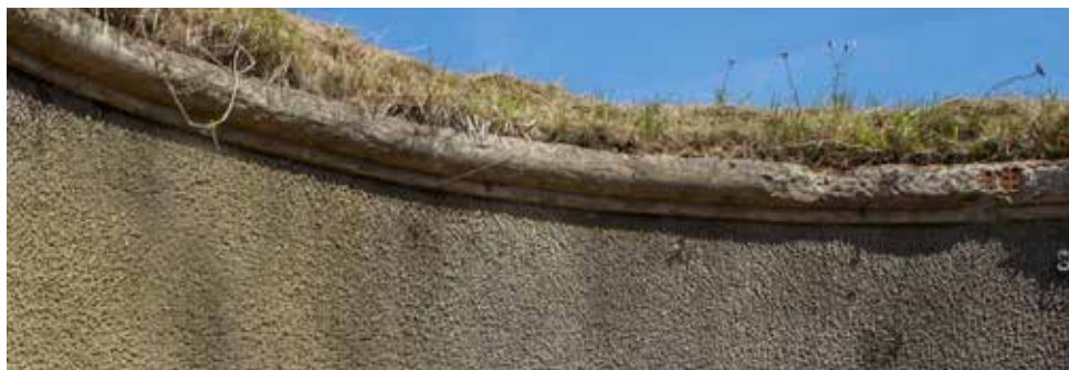
Cordón del revestimiento del parapeto de uno de los asentamientos circulares de la Obra de la Derecha.
