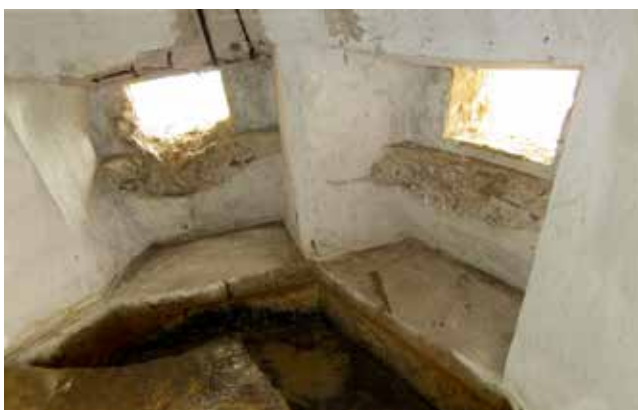
Centro de Resistencia 245 «Guadalupe». Interior de la obra 11, asentamiento para una ametralladora, situado 25 m al este de la «Sero-retxea» de Guadalupe y perfectamente visible desde la carretera. A pesar de tener dos aspilleras con sus correspondientes fosestes, sólo se le asigna una única arma.
