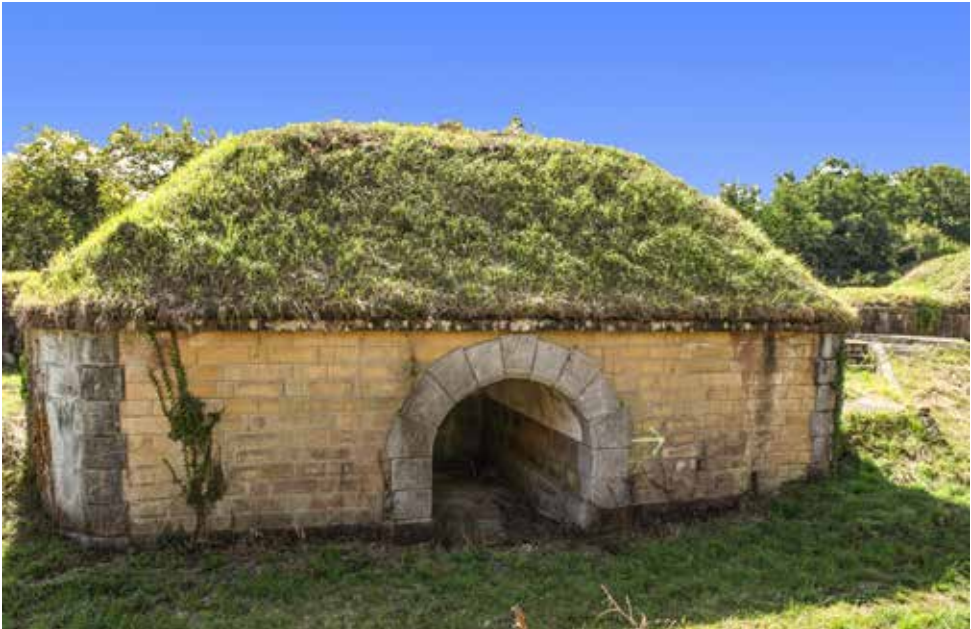
Abrigo (2) para artillería en el interior del través occidental de la Obra del Centro. Esta Obra tiene únicamente dos elementos de esta clase bajo los traveses extremos.
