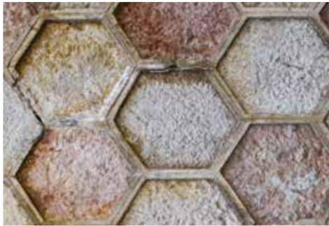
Mampostería concertada poligonal encintada reviste los muros del patio oriental.
