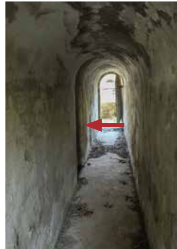
Comunicación y abrigo en el interior de un través. La flecha señala el acceso al repuesto de munición y al fondo la salida a otro de los asentamientos de la Obra del Centro.
