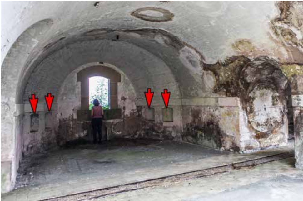
Localización de los cuatro repuestos de mano para proyectiles del Cañón de Hierro Entubado «Ordóñez» de 15 cm, en el frente norte de la batería acasamatada en la Obra de la Izquierda. Las casamatas en reserva (cañonera cerrada) no disponen de repuestos de mano.
