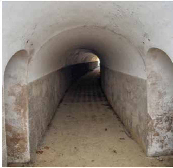
Caponera sureste. Poterna de comunicación (5) con el patio oriental. En primer plano los accesos a los repuestos de munición (2).
