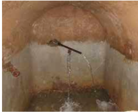
Interior del depósito de toma de aguas.
