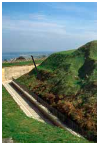
Ángulo NE del fuerte. La flecha señala el talud de escarpa.
