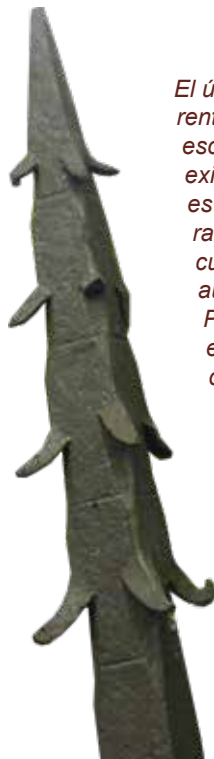
Verja defensiva de escarpa original en proximidad de la caponera SW, fotografiada hacia el año 1900 por Juan Roca. (© Patrimonio Nacional, Real Biblioteca). Coloreada. A Zócalo de mampostería revestido de arenisca. B Caballete formado por sillares calizos en los que se insertan postes y barrotes de la verja (Actualmente sustituido por hormigón). C Postes. D Refuerzos traseros metálicos de la verja. E Elementos salientes antiescalada.
