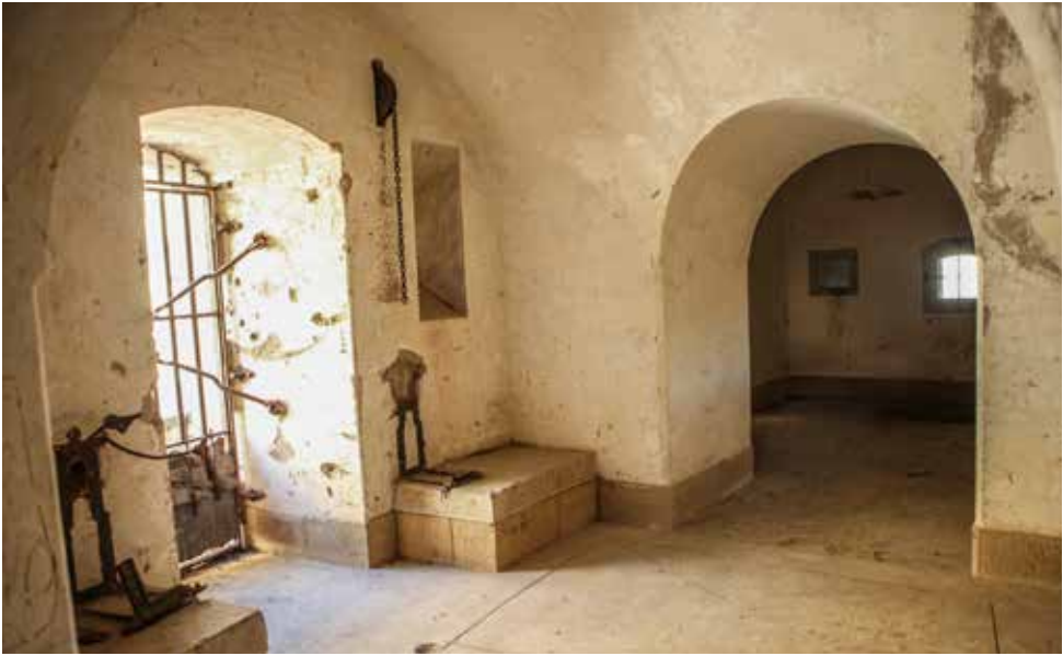
Estado actual de la puerta de guerra (a la izquierda) de la caponera de gola, con los elementos conservados del puente levadizo. A la derecha: casamata oriental de la caponera.
