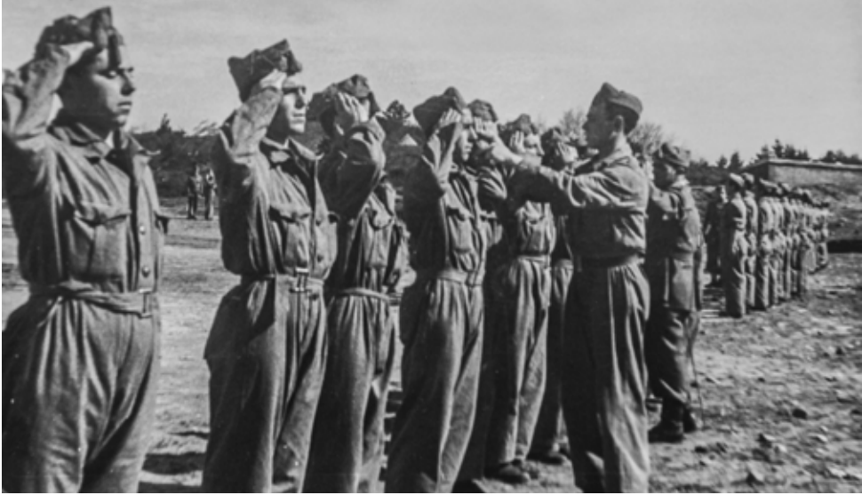
Campamento del Fuerte de Guadalupe. Instrucción de reclutas del regimiento de zapadores n.6 en el año 1950, a la derecha se aprecia el edificio de duchas y servicios (n. 6 del plano).
