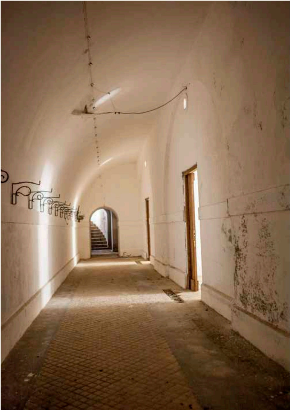
Interior del cuartel. A la derecha se abren las bóvedas, actualmente cerradas al mismo mediante un tabique con una puerta. Al fondo se aprecia la escalera curva de acceso al parapeto sobre la caponera de gola. En la pared izquierda se observan los soportes que sostenían la tabla de equipo. El suelo es el original del año 1900.
