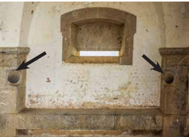
Boca interior de dos tubos lanzaproyectiles para defensa del refosete de la semicaponera oeste.
