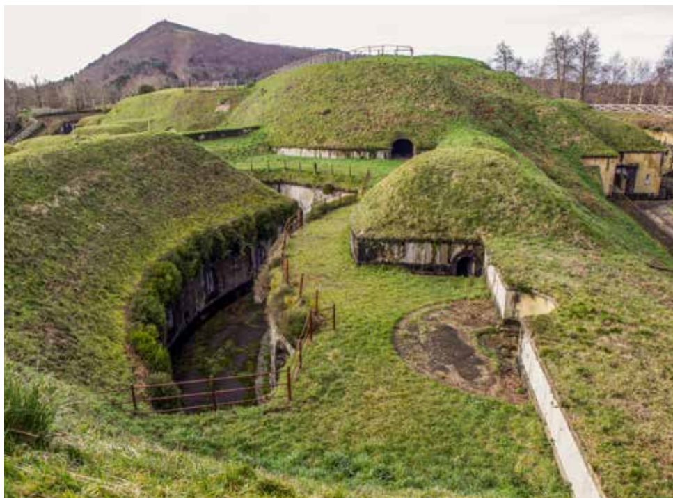
Vista parcial de este a oeste, tomada desde la máscara continuación del blindaje del cuartel de Artillería.
