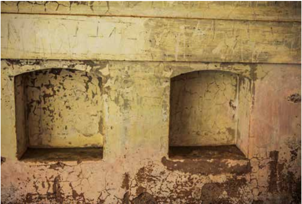
Detalle de los repuestos de mano para proyectiles del Cañón de Hierro Entubado «Ordóñez» de 15 cm, en el frente norte de la batería acasamatada en la Obra de la Izquierda
