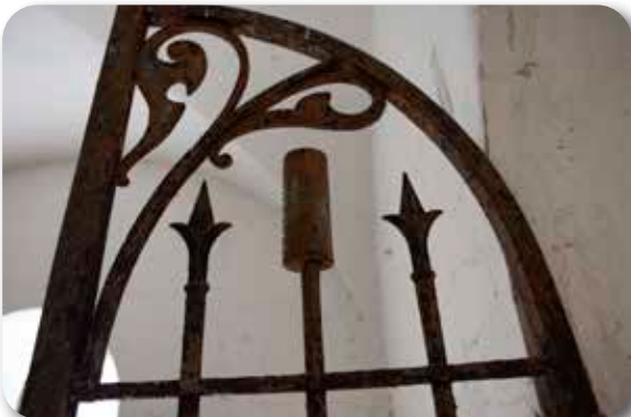
8 Acceso al repuesto munición de la batería de fuegos curvos de la Obra de la Derecha. Doble batiente.
