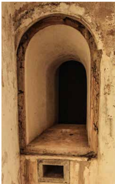
Ventana de luces de un depósito de distribución de munición de la Obra del Centro. El orificio inferior sirve para airear el interior del nicho. Falta la puerta de cierre.
