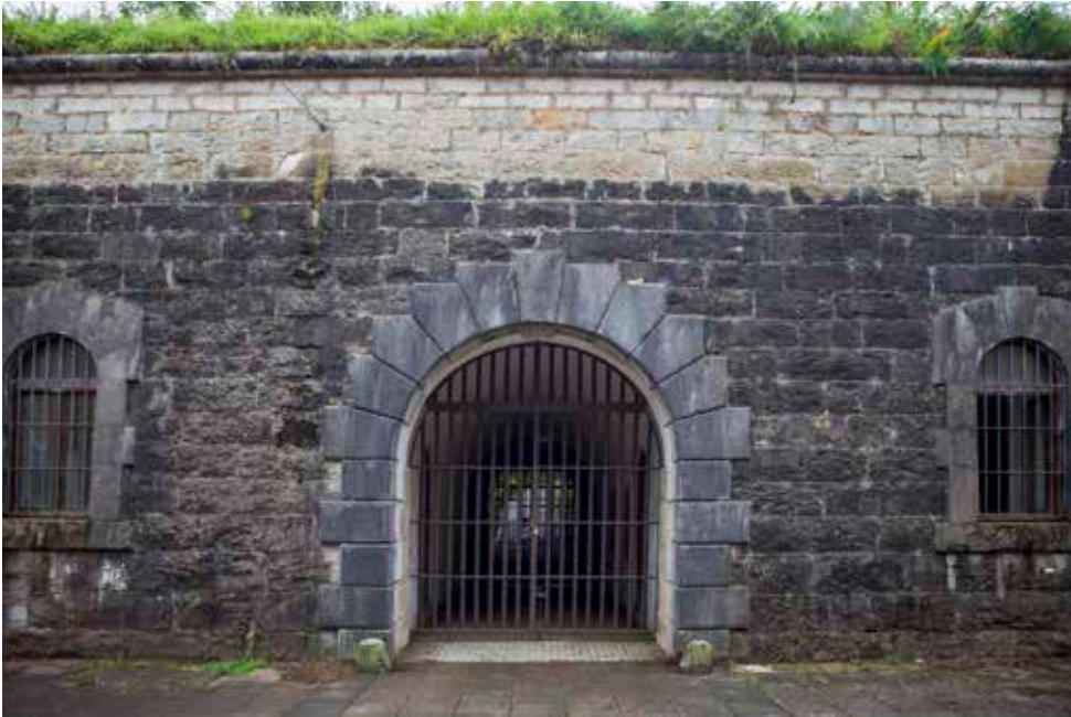
Desembocadura del túnel de acceso al foso en este último. Las ventanas a uno y otro lado corresponden a los cuerpos de guardia.
