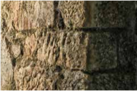
Grandes sillarejos desbastados forman las mamposterías del Fuerte.
