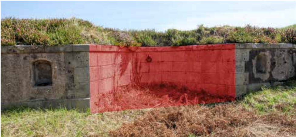
Semicilindro entrante (en rojo) en el parapeto del frente este de la Obra de la Derecha.
