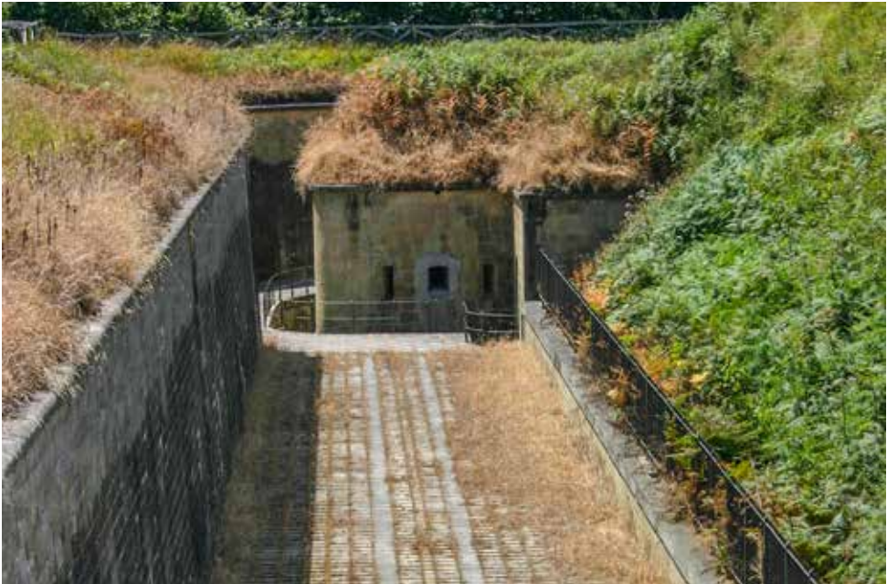
Caponera sureste (3) flanqueando un sector del foso mediante una cañonera y dos aspilleras. Se aprecia que la cota de la caponera es claramente inferior a la de la contraescarpa para de esa manera dificultar por desenfilada el impacto de proyectiles enemigos. A la izquierda de la fotografía se observa la contraescarpa y a la derecha el zócalo de mampostería revestido de sillar de arenisca y sobre él la verja de escarpa.
