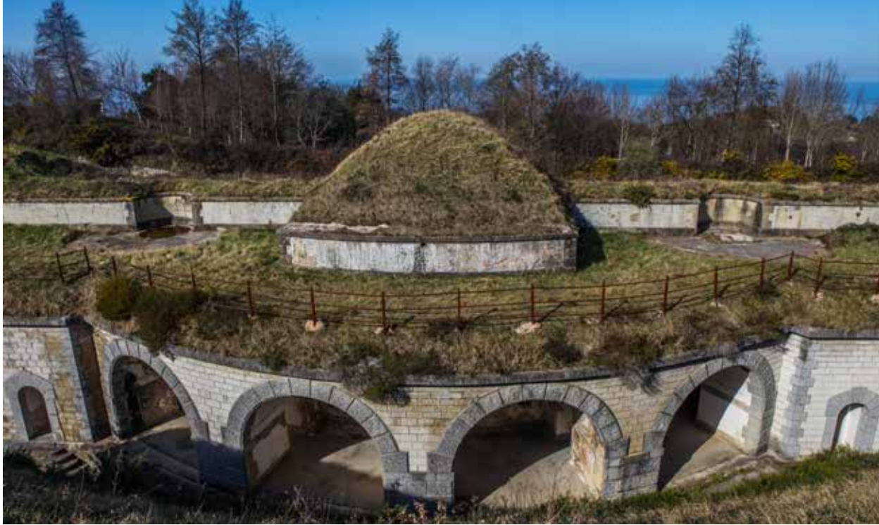
Batería de fuegos curvos de la Obra de la Derecha. Tuvo asignados cuatro morteros de bronce «Mata» de 15 cm. Sobre ella se dispone una batería de costa con un través.
