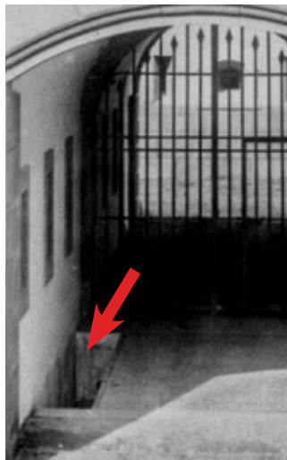
Foso de la antepuerta, con su puente original entreabierto. A la izquierda se aprecian varias aspilleras.
