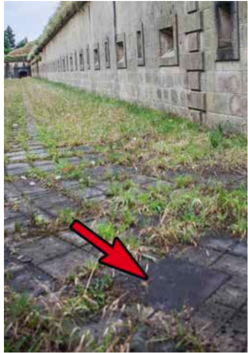
Uno de los registros actuales de la red de saneamiento a su paso por el foso
