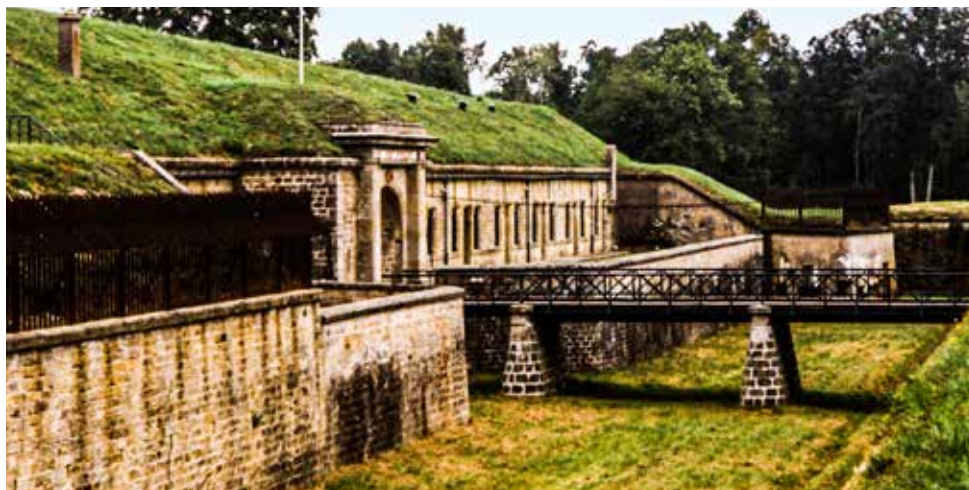
Fuerte de Uxegney (1882-1884) (Épinal, Francia) , sigue la tipología de fortificación del sistema Séré de Rivières, perteneciendo a la época en la que el general ya había dejado de dirigir los trabajos de fortificación. El Fuerte sufrió diversas modernizaciones en su interior. Al fondo, tras el puente que cruza el foso, se aprecia la única caponera de flanqueo del foso, pues el resto de los flanqueos fueron encomendados a cofres de contraescarpa.
