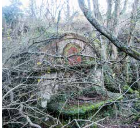
Depósito de toma de aguas.
