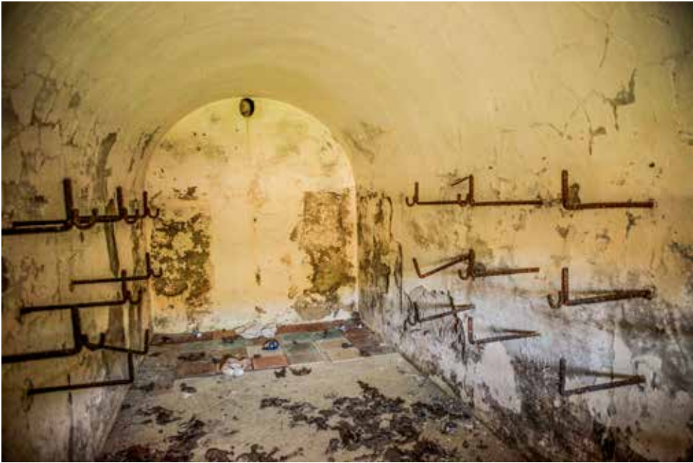
Soportes para los juegos de armas en el almacén de efectos de artillería de la Obra del Centro.
