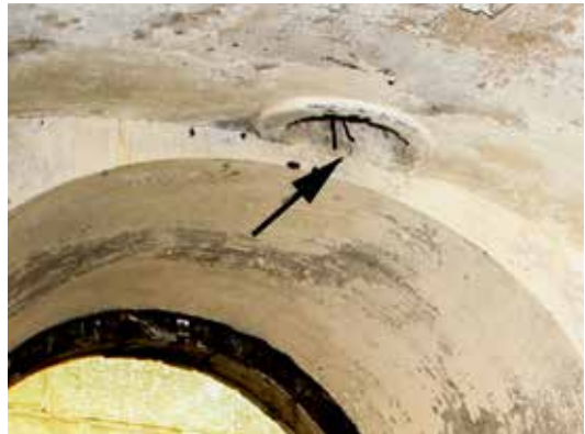
Cuartel de infantería: parte superior de ventanas y puertas al patio. Las bóvedas cerradas tienen otro ventilador que comunica cada una de ellas con el pasillo.
