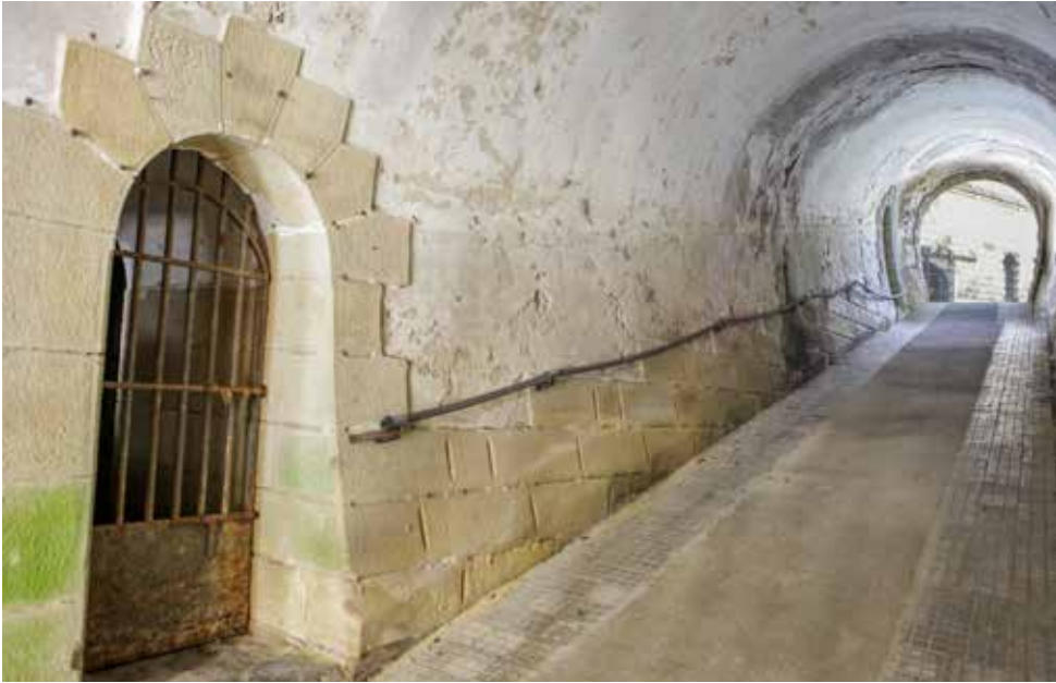
Acceso al cuerpo de guardia de la izquierda donde, al parecer, se almacenaron gran parte de las partidas de explosivos en tránsito. Al fondo, el patio de armas.
