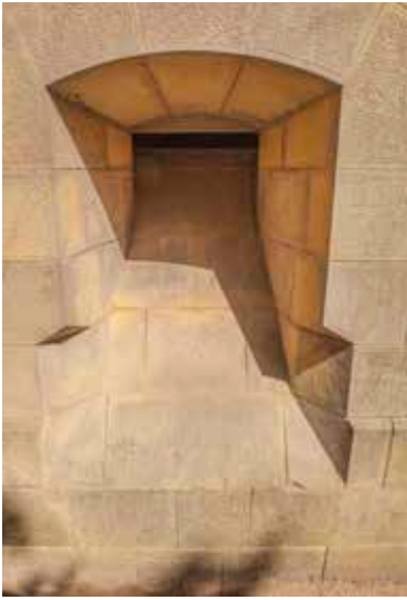
Vista frontal de un matabacán. Las alas de la parte inferior permiten aumentar el ángulo de tiro.
