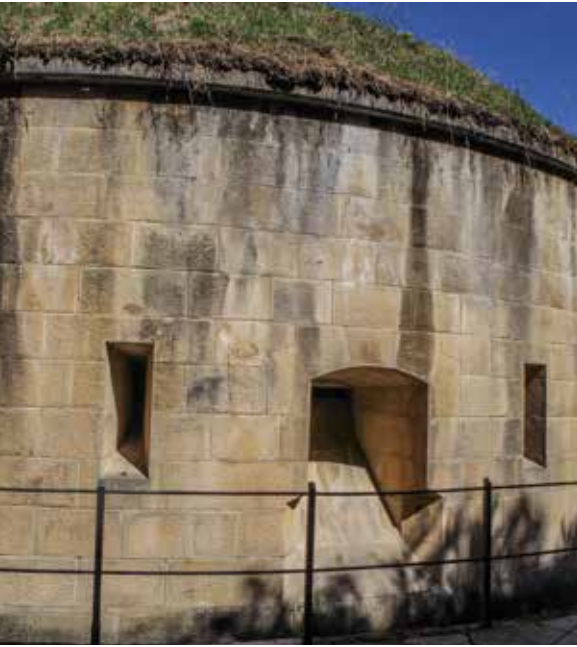
Caponera sureste. Vista desde el foso en el lugar donde no está flanqueada por artillería. Se aprecian los matacanes para defensa del refosete y dos aspilleras para defensa del tramo del foso.
