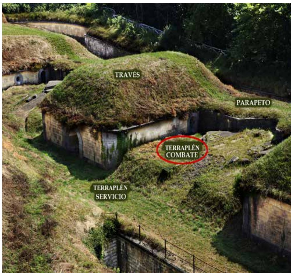
Obra del Centro. Se han señalado: el parapeto (cota 184,5 m ), el terraplén de combate (cota 182,7 m) y el terraplén de servicio (cota 181,15 m ). Las cotas se corresponden con las consignadas en el proyecto.
