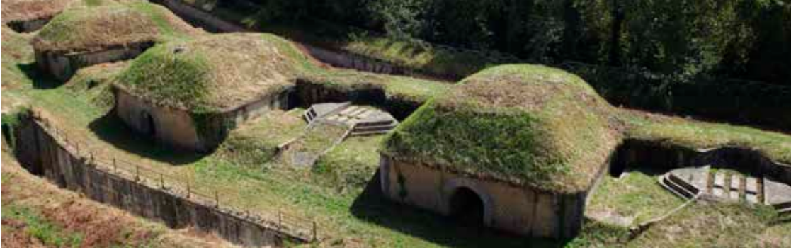
Los tres traveses de la Obra del Centro disponen, en conjunto, de abrigos para el personal que sirven también de paso a cubierto de unión de los cuatro emplazamientos, dos repuestos, dos abrigos para artillería ligera y la estación superior del montamunición.
