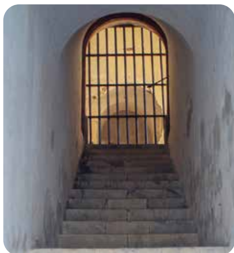
La escalera que comunica el cuartel de infantería con la batería acasamatada tiene tres tramos, incluyendo un recodo.
