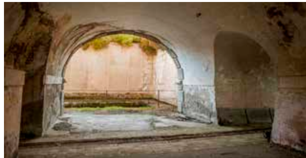
Obra de la Izquierda. Batería fuegos curvos.
