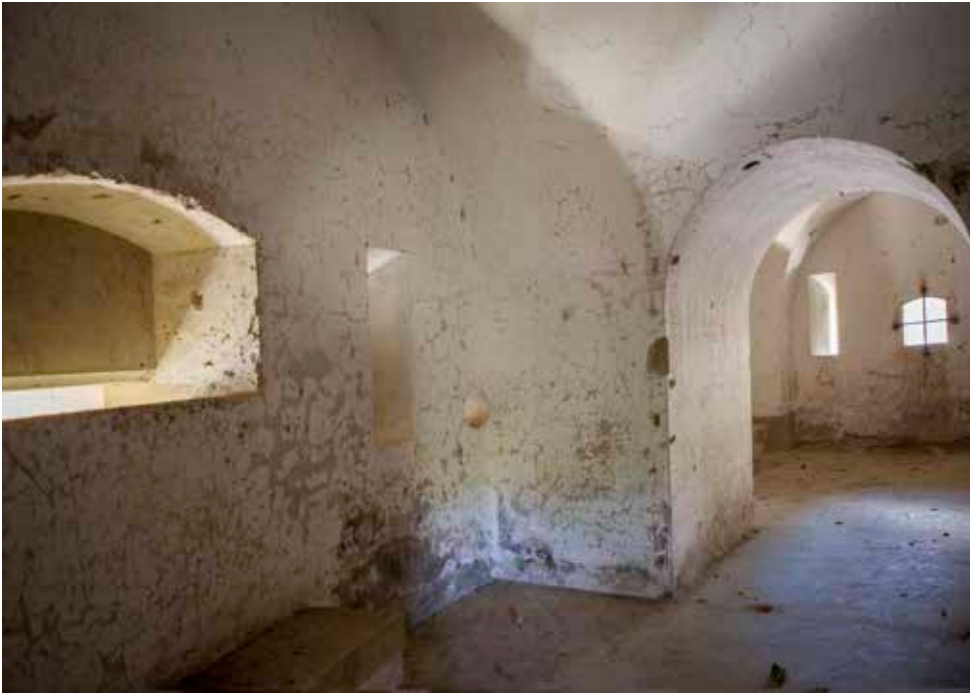
Caponera suroeste. Al fondo, la casamata frente occidental (1b) que flanquea el sector de foso que corresponde al acceso al Fuerte. En primer plano la bóveda (10) que comunica las dos casamatas de la caponera, apreciándose un matacán, una aspillera y un lanzagranadas.
