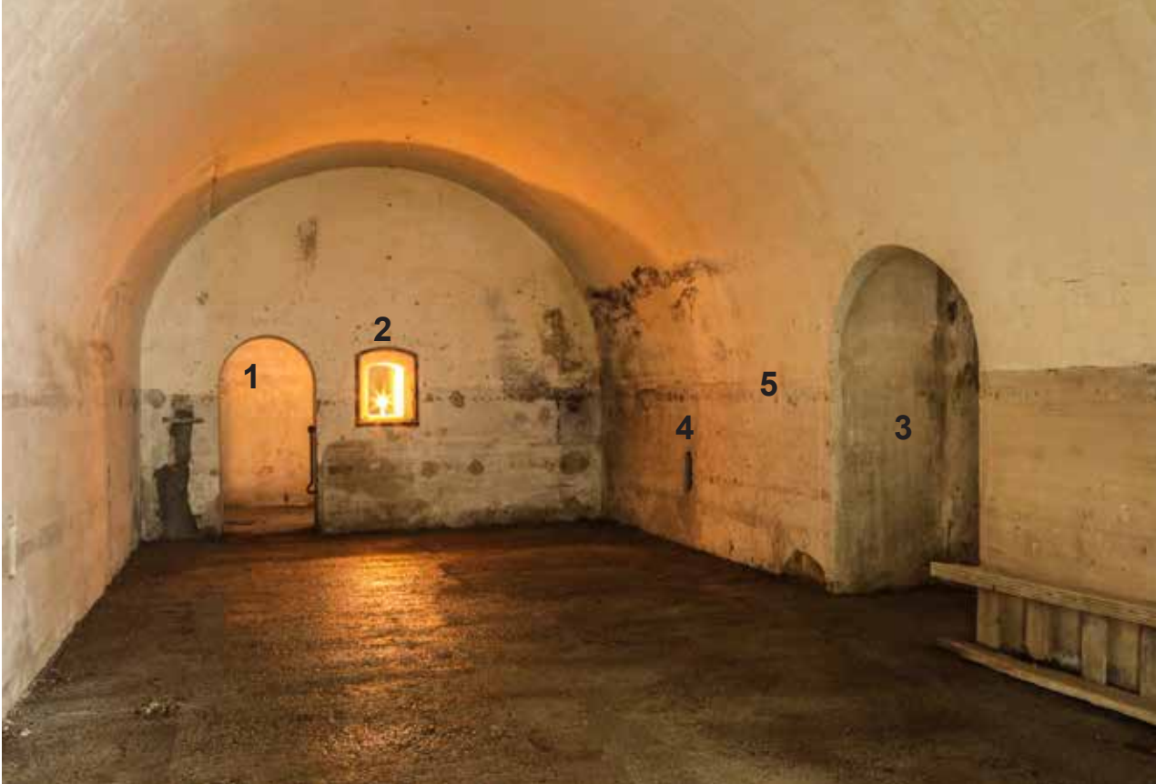
El Depósito de distribución de munición de la Obra de la Izquierda dispone de una bóveda de grandes dimensiones, con accesos por un extremo desde el patio y por el otro desde el cuartel (1). Posee dos nichos de luces (2) y un montamunición (3). Dispone de un sistema de ventilación (4) y vestigios del revestimiento de las paredes (5) de madera hasta el arranque de la bóveda. El suelo estaba también entarimado, formando una cámara de aire.
