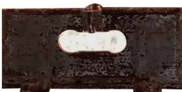
Izda. aspilleras de la galería de escarpa. Dcha. Porta metálica de una aspillera horizontal del sector norte de la galería de escarpa posee dos pernios, cerrojo y mirilla de tiro.
