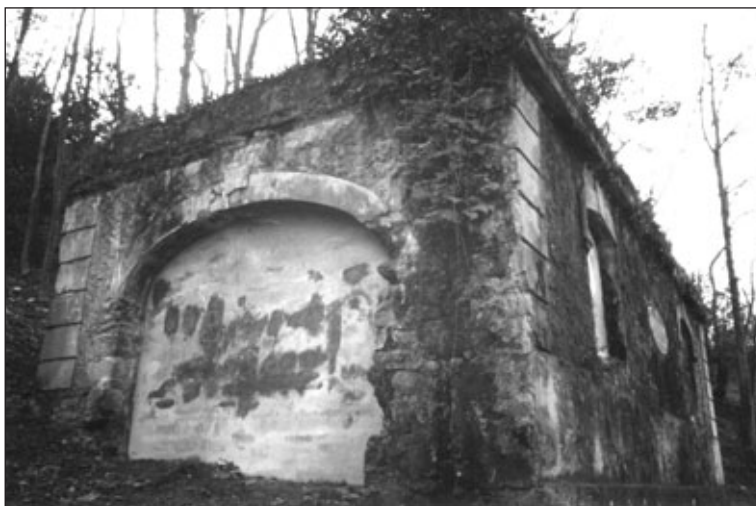
Galería de tiro. Pabellón de abrigo y guardablancos
