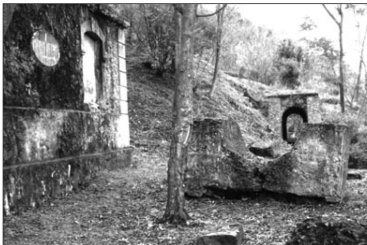
Galería de tiro. Vista desde la plataforma de tiradores. Puede observarse, descabalgando, uno de los arcos mampara y, al fondo, el túnel
