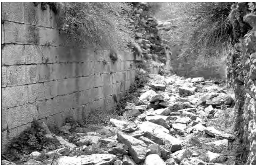
Bateria de la Sagüeta. Foso occidental. Puede observarse la escarpa revestida de sillarejo y la contraescarpa, tallada en la roca natural. El fondo cubierto de materiales diversos resultado del paso del tiempo
