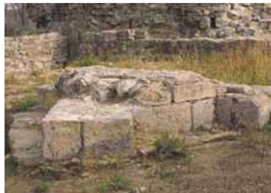
Una de las bases en las que se apoyaría la estructura de madera que permitiría el disparo desde las troneras superiores.
