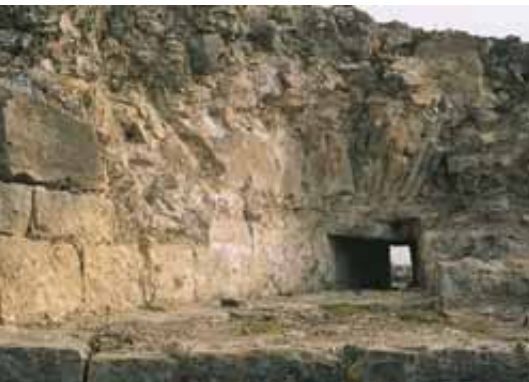
Cañonera superior cegada en el lienzo donde se encuentra el acceso.
