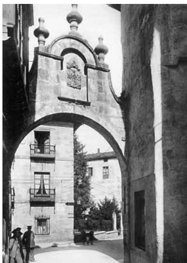
Todavía se conservan, más o menos modificadas, algunas puertas de las murallas medievales. Por ejemplo el arco de San Ignacio en Salinas de Léniz (arriba) o el portalón de Arrasate / Mondragón (abajo). (A. G. Lo admirable de Guipúzcoa. Bilbao 1932).
