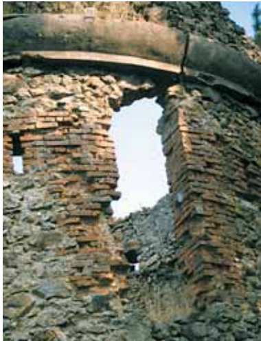
Detalle de aspillera y lucerna semicircular del torreón Pika.
