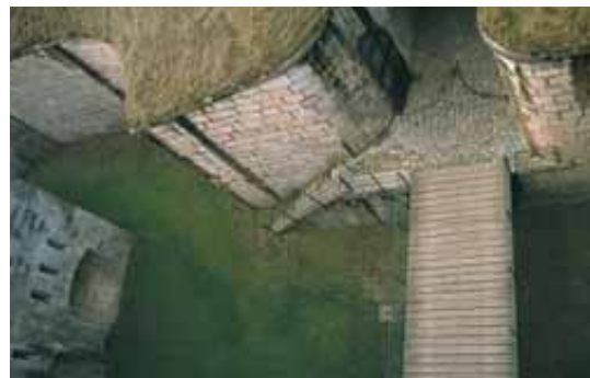
Foso, al fondo la semicaponera, dotada con dos cañoneras para ametralladoras y varias aspilleras verticales para fusilería.
